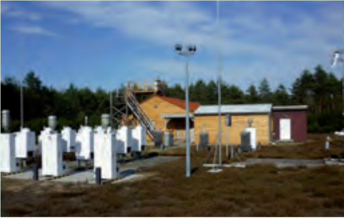
Die UBA-Messstation Waldhof in der Lüneburger Heide. Im Vordergrund das Messfeld mit Sammelgeräten für Feinstaub und Niederschlagswasser, im Hintergrund das Stationsgebäude, in dem sich Messraum, Labore und Büros befinden. Die Messplattform vor und über dem Stationsgebäude dient speziellen Quecksilbermessungen
