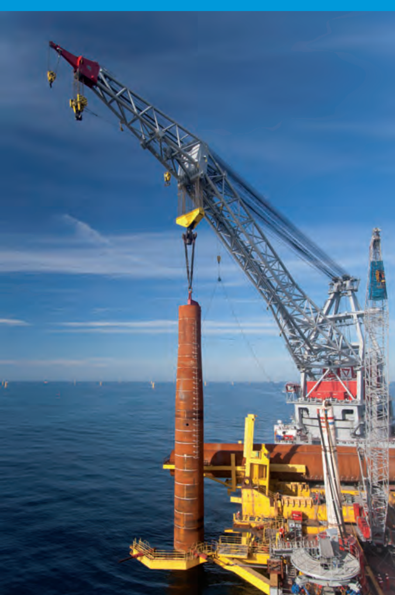
▲ Bau einer Offshore-Windkraftanlage
