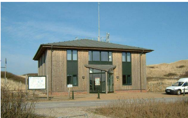
Die Messstation Westerland
