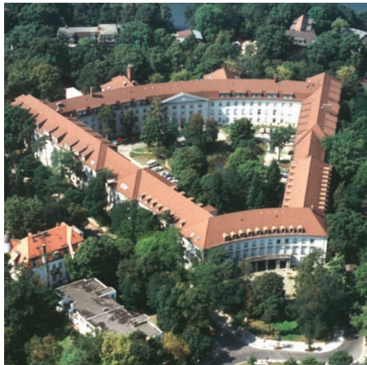
Abbildung 2: Das Dienstgebäude des UBA am Bismarckplatz in Berlin-Grunewald
