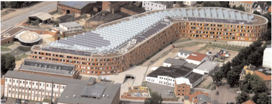
Abbildung 1: Das neue Dienstgebäude des Umweltbundesamtes in Dessau-Roßlau (Foto: Busse).
