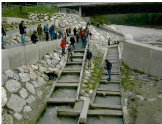
Abb. 3: Zwei Formen sinnvoller Fischwanderhilfen – der naturnähere Umleitungskanal ist in diesem Fall kostenintensiver, bietet aber zusätzliche Laichgebiete.
