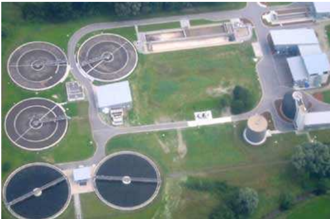
Abb. 7.1.6: Ansicht Kläranlage Baarbachtal
