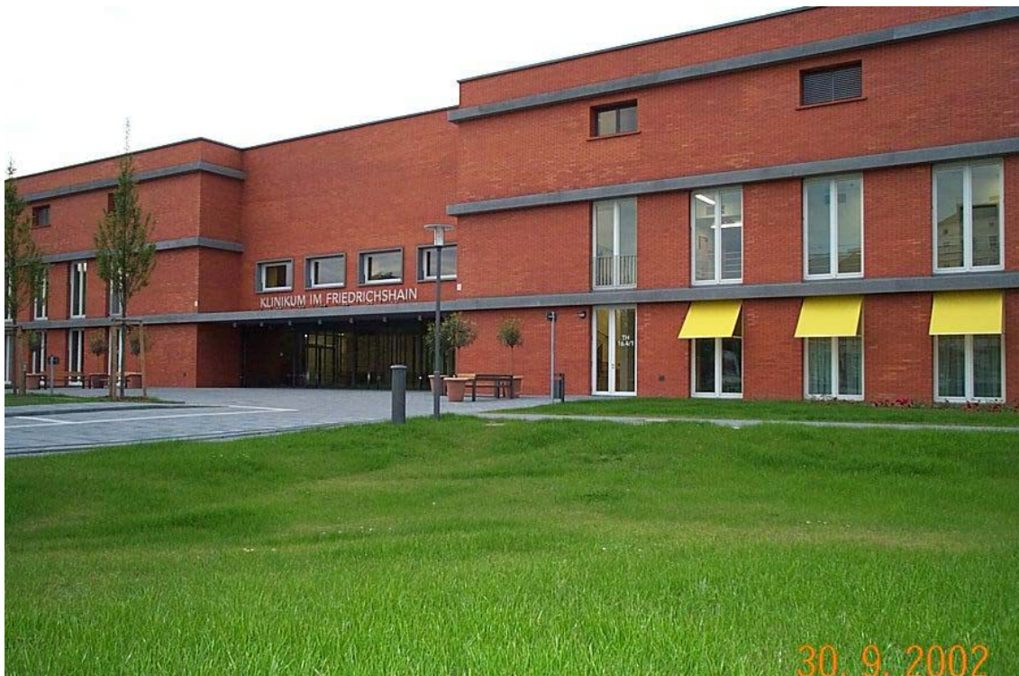
Abb. 12: Eingangsbereich Krankenhaus im Friedrichshain mit Entwässerung über Mulde
