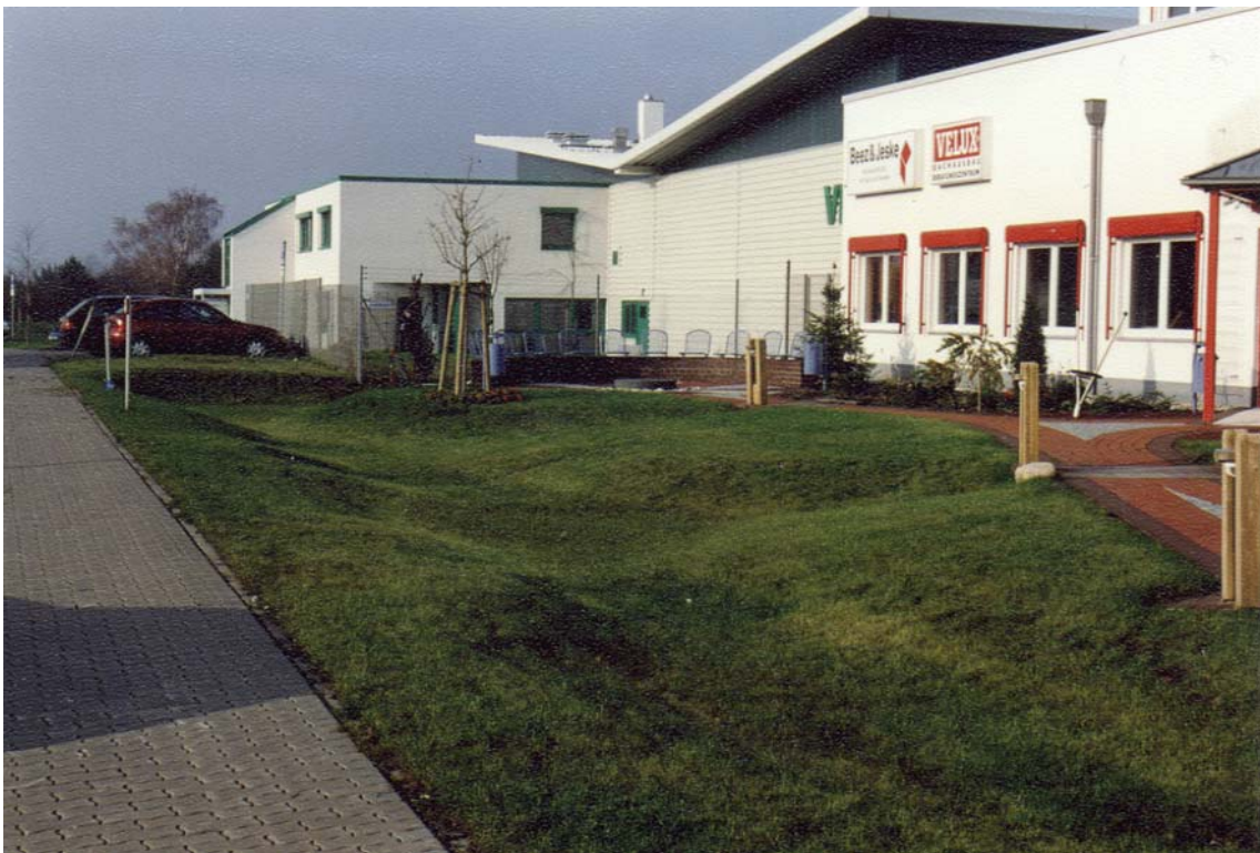
Abb. 2: Mulden-Rigolen-System auf den Grundstücken der Investoren
