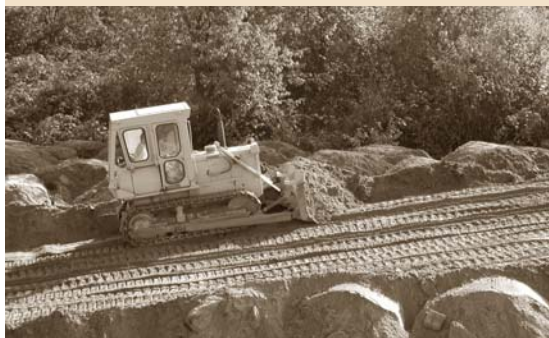
Abbildung 8.1-1: Bodenmaterialumlagerung mit Raupe
