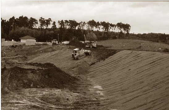
Abbildung 8.1-3: Abdeckung der Mülldeponie Westheim (Foto: Egloffstein)
