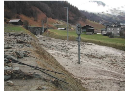
Photo: Durch einen Murgang verschüttete RhB-Bahnlinie (22.11.2002 in Campliun-Trun, Kt. Graubünden, CH); Eva Frick, tur gmbh, Davos
