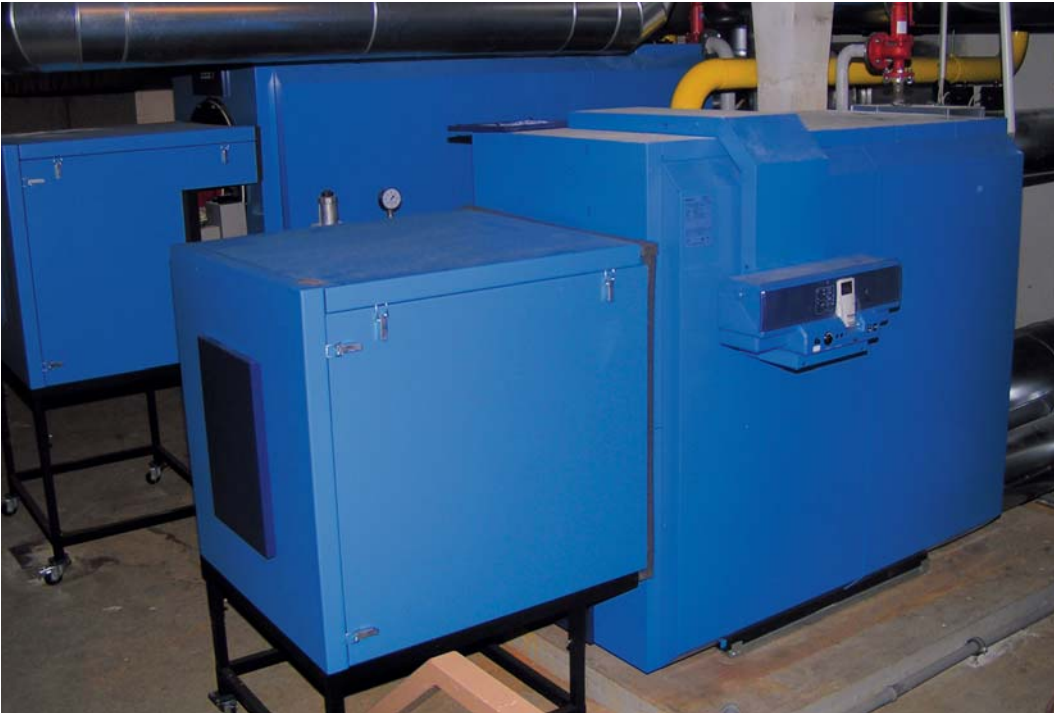
Abb. 6: Erdgas-Brennwert-Heizkessel im Dienstgebäude Bismarckplatz
