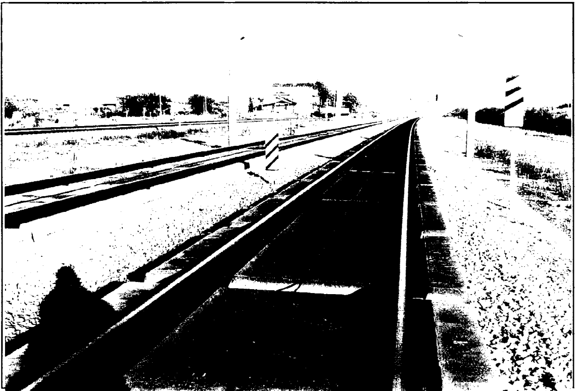
Abbildung 2.5e Gleisanlage in Richtung Berlin
