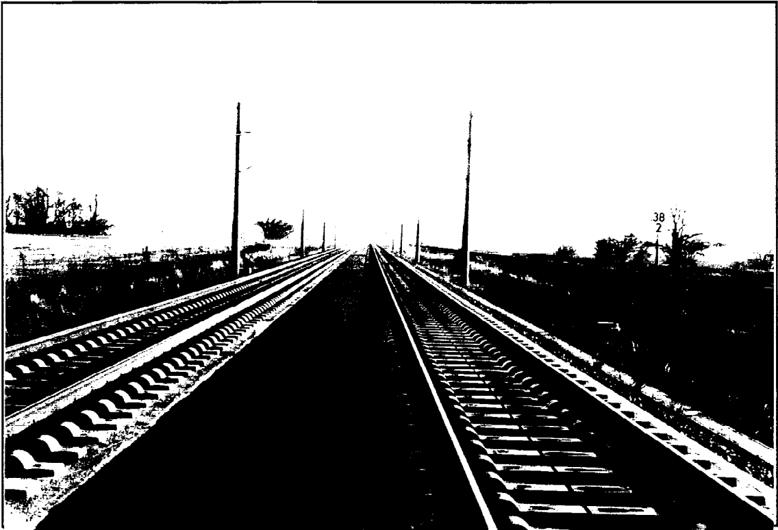
Abbildung 2.3e Gleisanlage in Richtung Berlin
