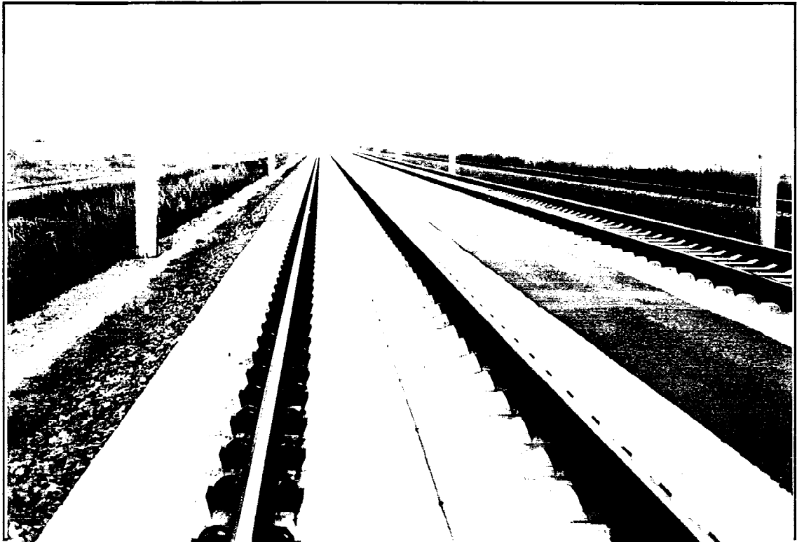
Abbildung 2.6e Gleisanlage in Richtung Berlin
