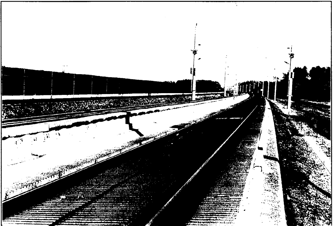
Abbildung 2.4e Gleisanlage in Richtung Berlin
