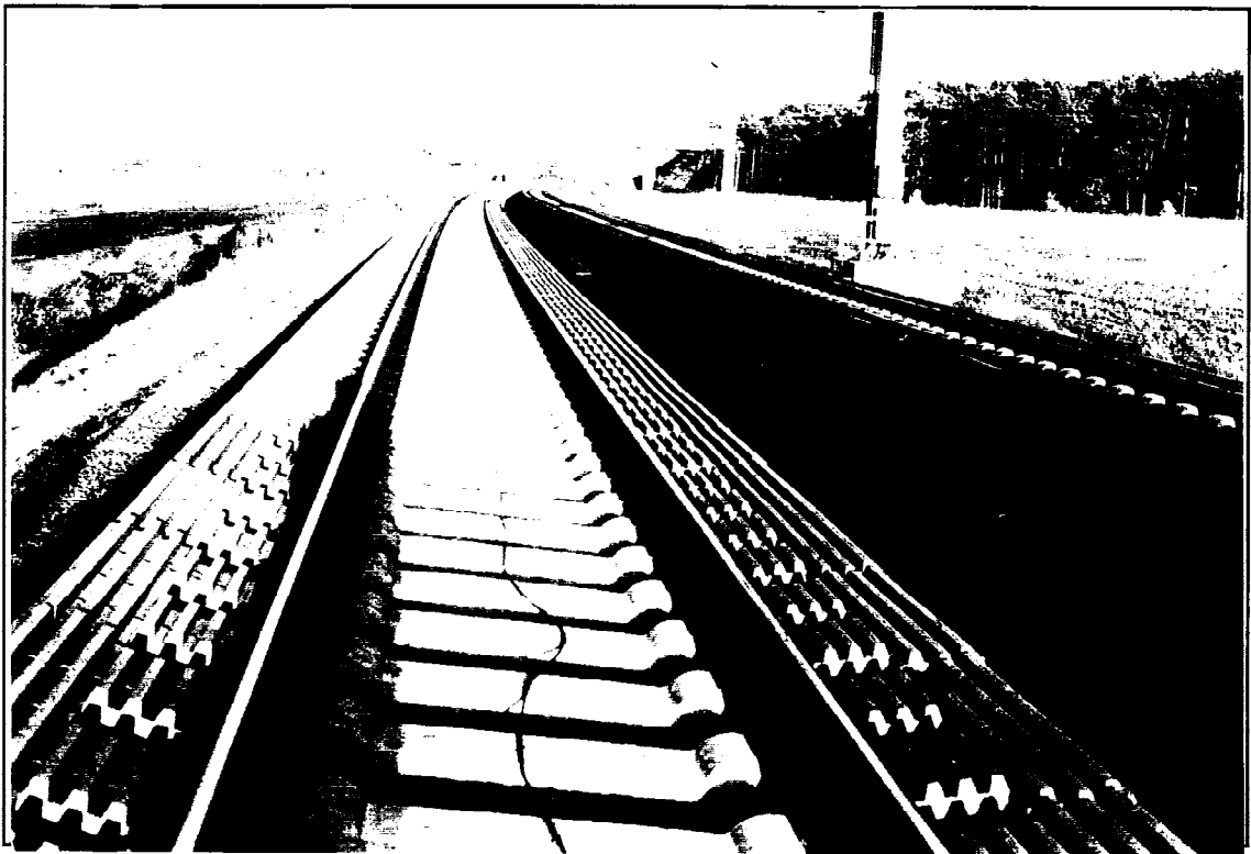
Abbildung 2.8e Gleisanlage in Richtung Berlin
