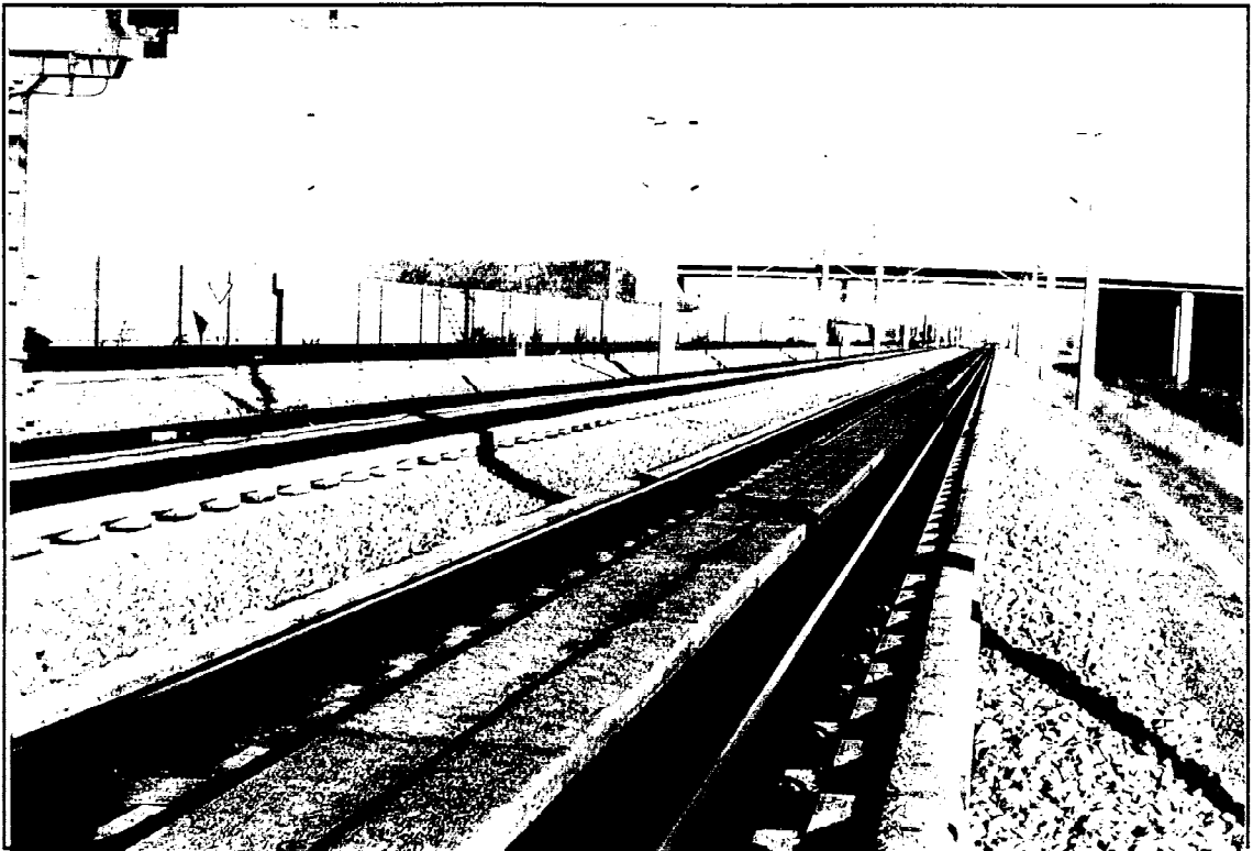
Abbildung 2.7e Gleisanlage in Richtung Berlin
