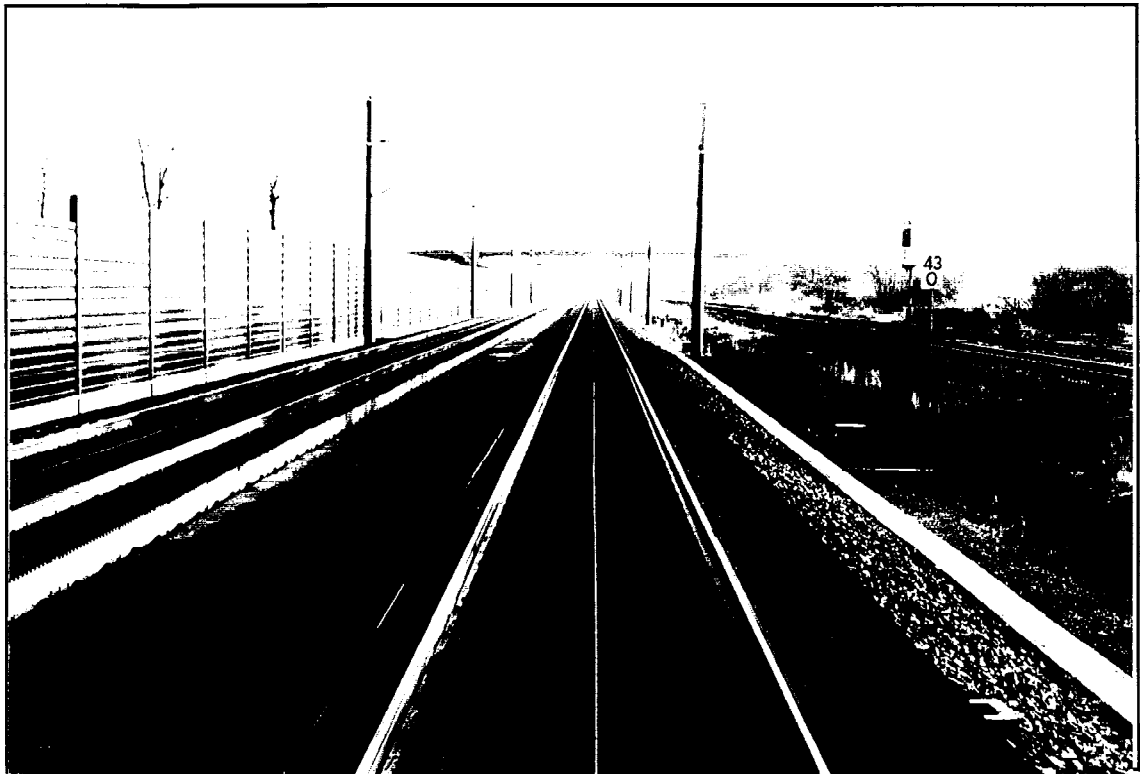
Abbildung 2.1e Gleisanlage in Richtung Berlin
