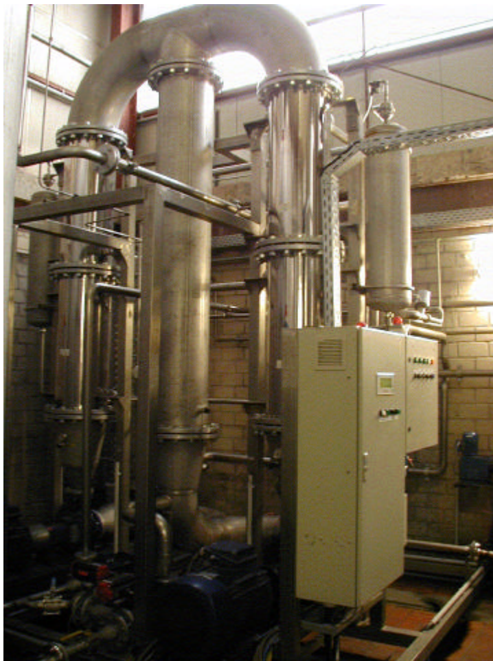
Abbildung 4.52: Ultrafiltration mit Tubularmodulen als Teil der beschriebenen Anlage zur Behandlung von Abwasserteilströmen mit Recycling
