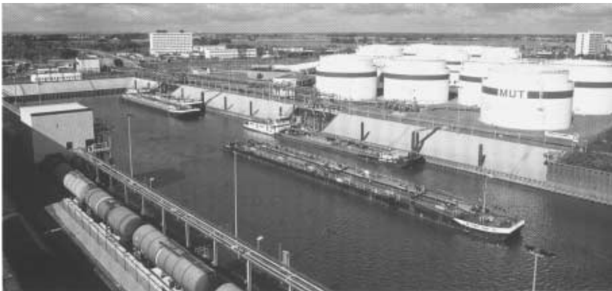
Abb. 59: Binnen-Tankschiffhafen mit Tanklager (Magdeburg / Elbe)
