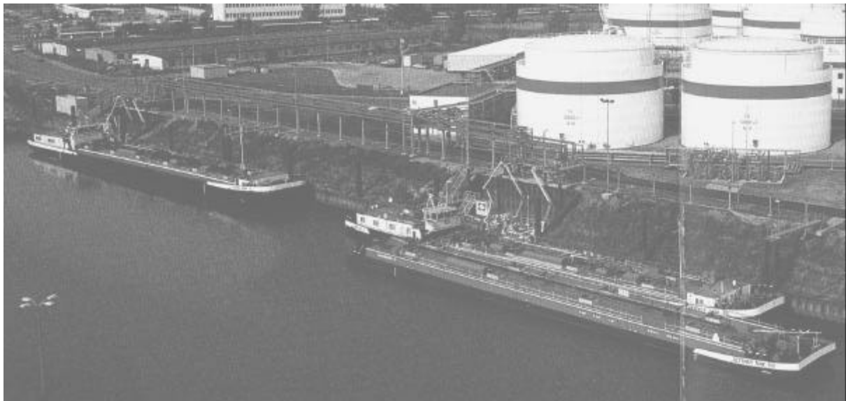
Abb. 42: Tank-Motorschiffe und Tank-Koppereinheiten am Mineralöl-Tanklager (Magdeburg)
