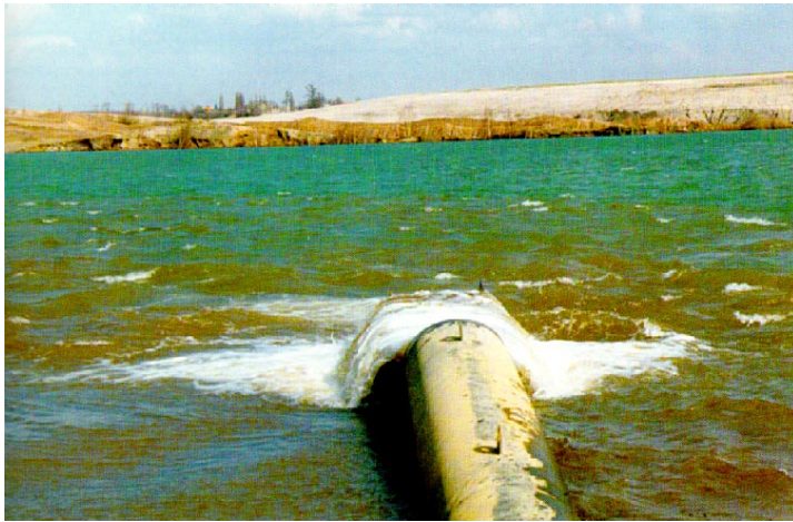
Abb. 134: Zulauf zum See Cospuden aus der Wasserüberleitung vom Tagebau Profen (Haferkorn et al. 1999)
