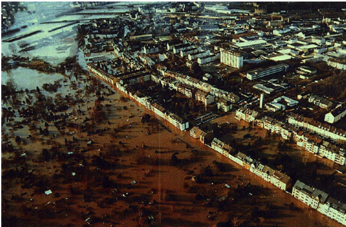
Abb. 2: Hochwasser 1993/1994, Koblenz, Vorort Neuendorf/Rhein
