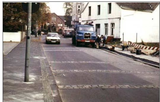
Bild 4.25: ...wirkt Pflaster geräuscherhöhend.
