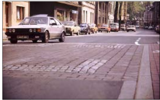
3.19: Pflasterkissen mit steiler Rampe
