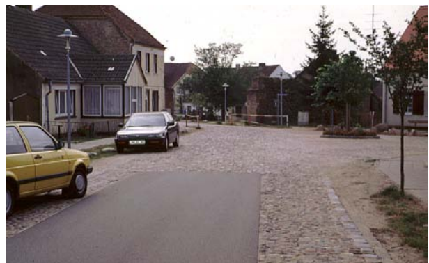
Bild 4.9: Falsch eingesetzter Pflasterbelag
