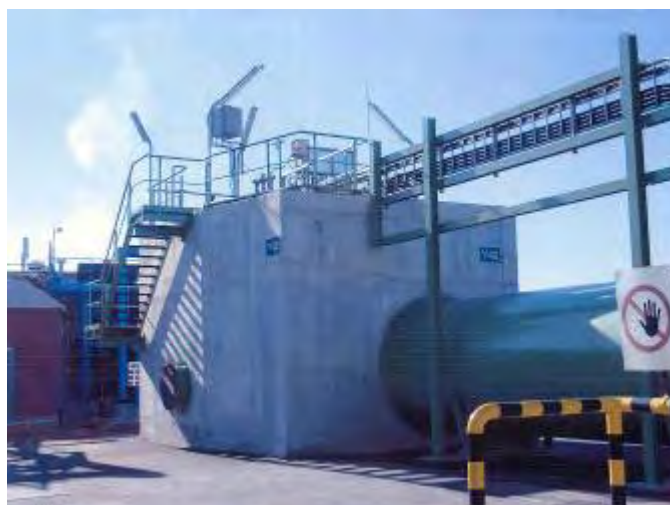
Abbildung 6.5.4.2.5: Pumpwerk mit Rohrleitung zur Ableitung von Oberflächenwasser und Kühlwasser in den Rhein
