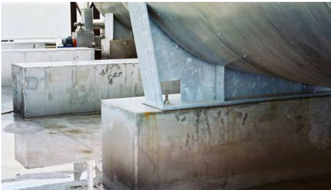
Abbildung 6.6.3.4.3: Verschraubung der Lagersättel
