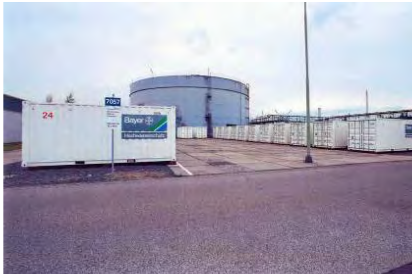
Abbildung 6.5.4.2.3: Vorhaltung der mobilen Schutzwand in 24 Containern
