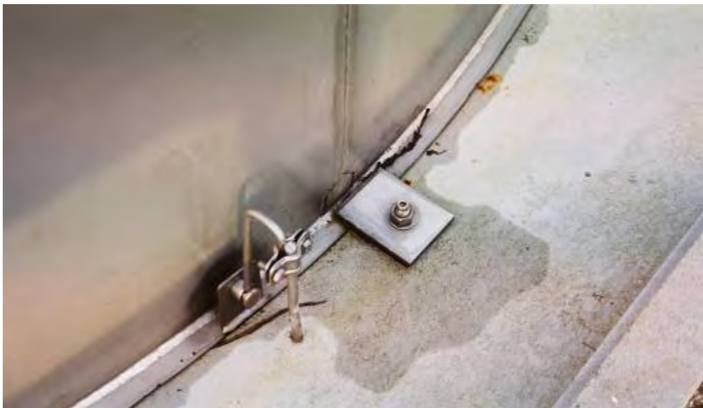
Abbildung 6.6.3.4.5: Sicherung eines Tanks gegen Aufschwimmen
