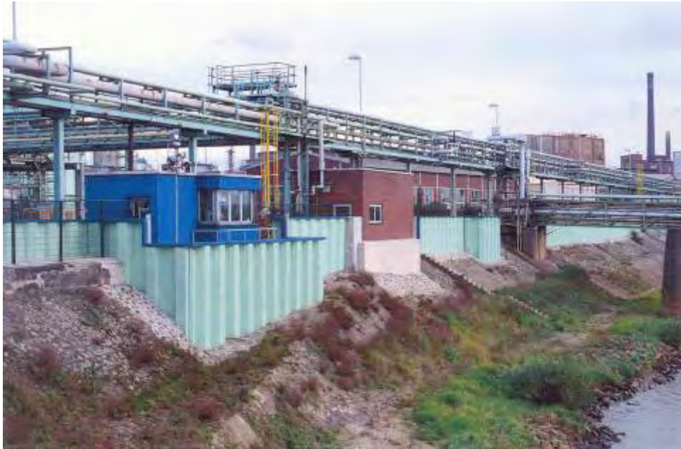
Abbildung 6.5.4.2.2: Teilansicht der stationären Hochwasserschutzwand
