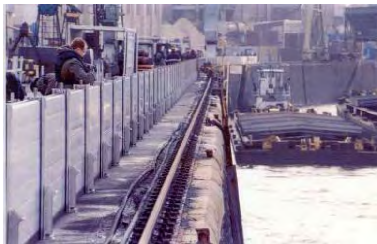
Abbildung 6.5.4.2.6: Aufbau der mobilen Hochwasserschutzwand am Chemiestandort Leverkusen
