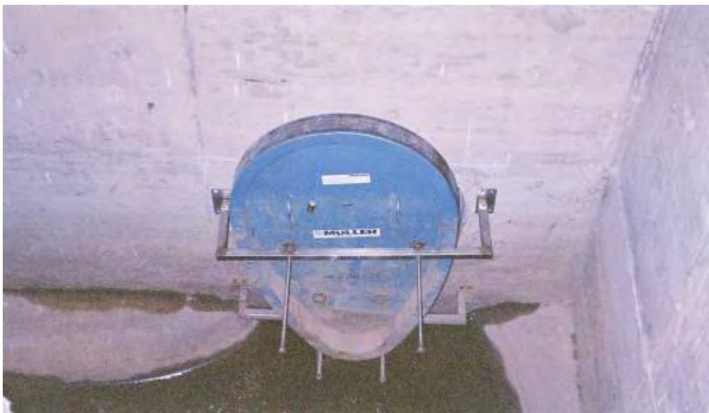
Abbildung 6.6.3.4.1: Abdichtungssystem im Kanalschacht der Hermania Schirm AG, Schönebeck
