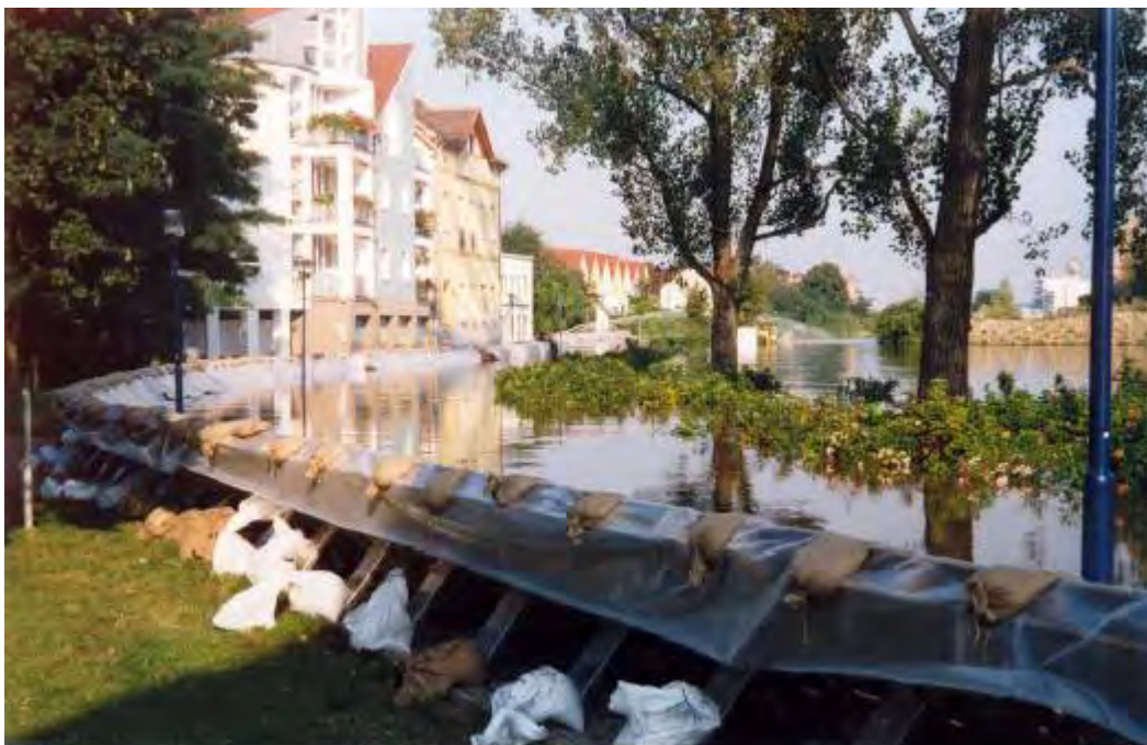
Abbildung 6.6.3.3.2: Mobile Hochwasserschutzwand in Schönebeck
