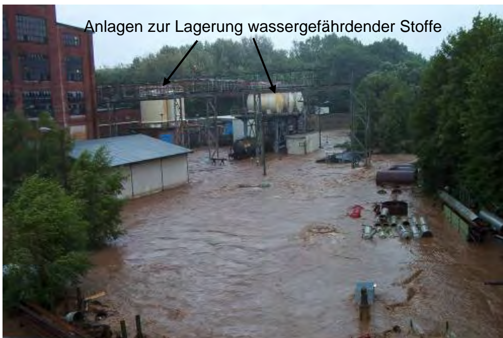
Abbildung 6.7.2.3.3: Durchströmung der Betriebsfläche mit Treibgut: Blick gegen die Fließrichtung
