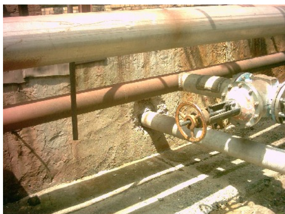
Фотография 9: Прокладка трубопровода внутри приёмной ванны
