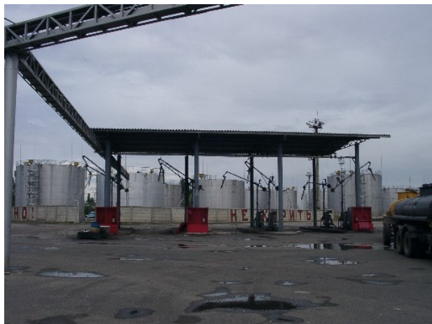
Фотография 1: Станция по наполнению автоцистерн; на заднем плане - ёмкости для хранения, не оснащённые достаточно вместительными поддонами
