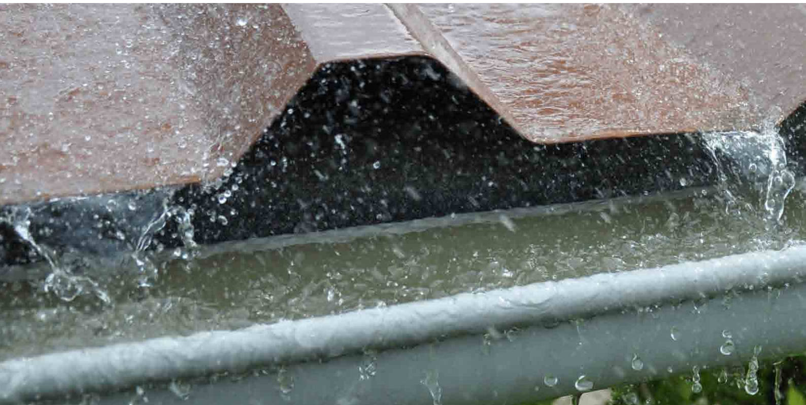
Abb. 5.4.1: Überlauf einer Dachrinne nach einem Starkregenereignis [5].
