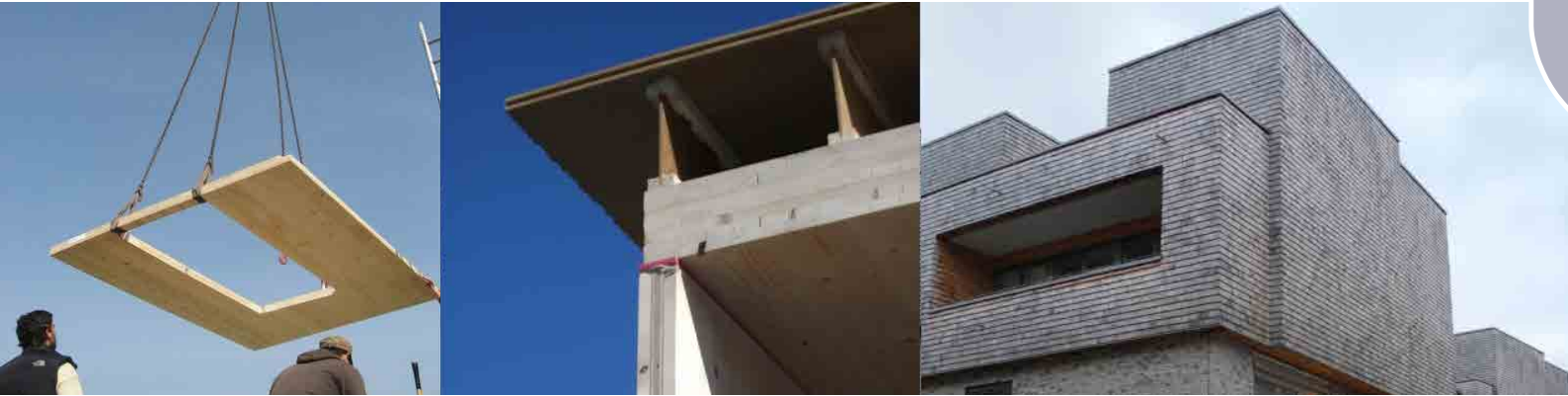
Abb. 5.8.1: (links und mitte) Bau des Versuchshauses aus Massivholz auf FH-Campus (G. Conradi) Abb. 5.8.2: (rechts) Dachaufstockung am Beispiel der „Treehouses“ Bebelallee 64-70 in Hamburg (S. Slama).
