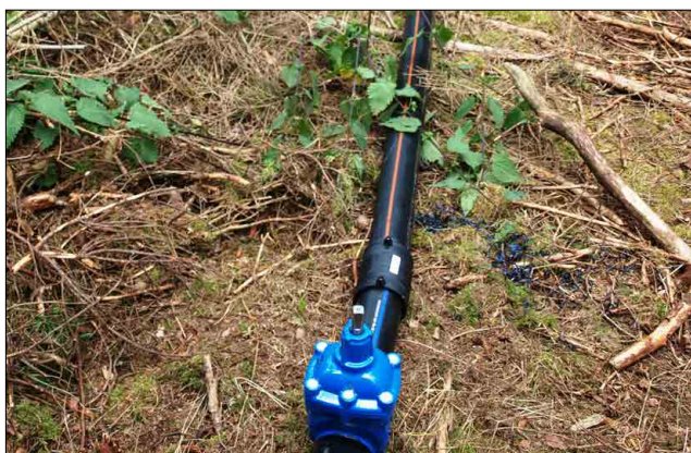
Abb. 6.5.3: Schlauchsystem zur Versickerung von Klarwasser im grundwasserfernen Kiefernwald (E. Eiben)
