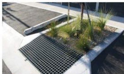
Abb. 26 Einleitung wenig belasteter Straßenabflüsse in Pflanzgrube
