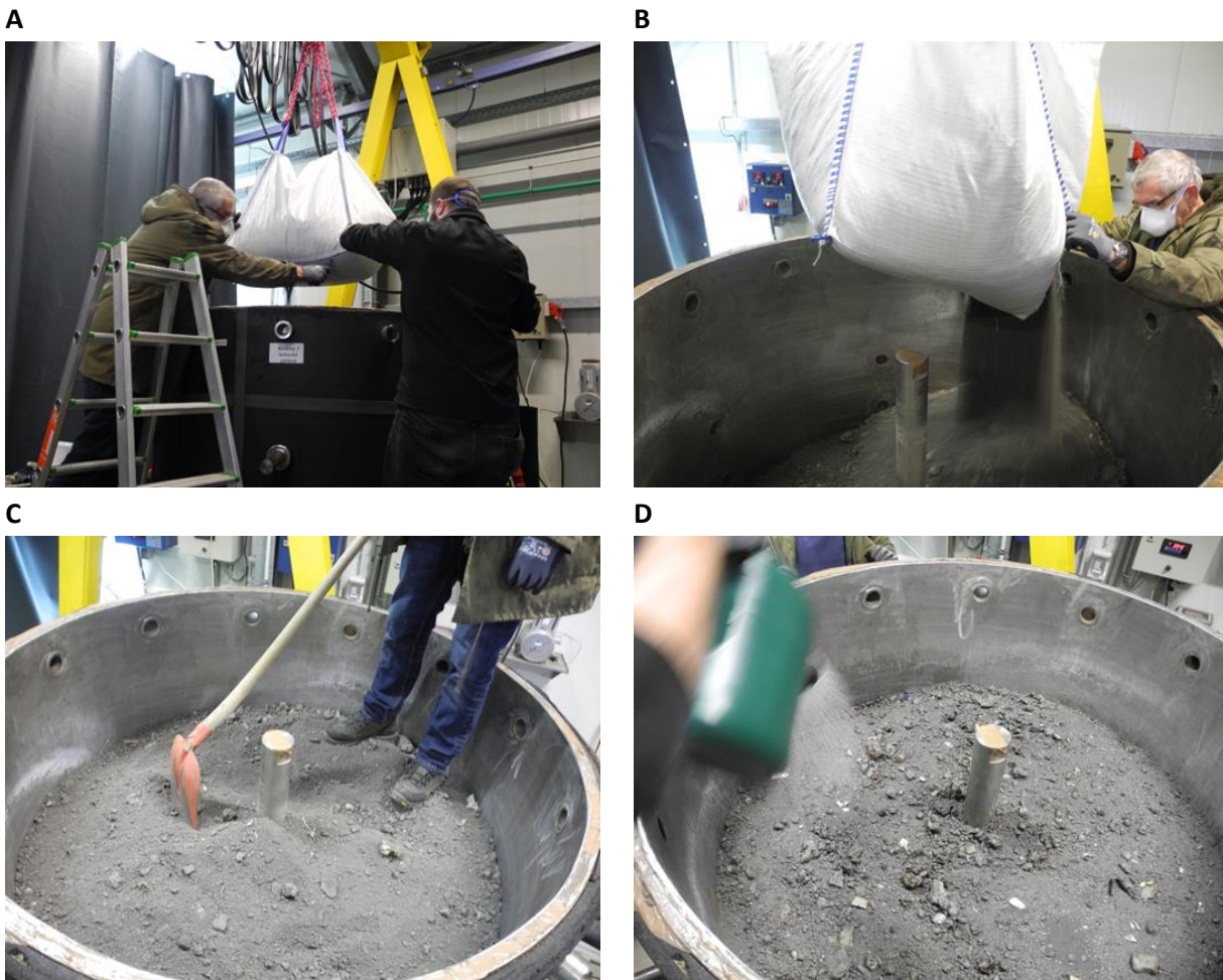
Abbildung 82: Einlagerung des Schlackegemisches (A + B + C) und leichte Befeuchtung während der Einlagerung (D).
