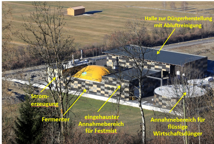
Abbildung 90: Anlage der Biogas Wipptal
