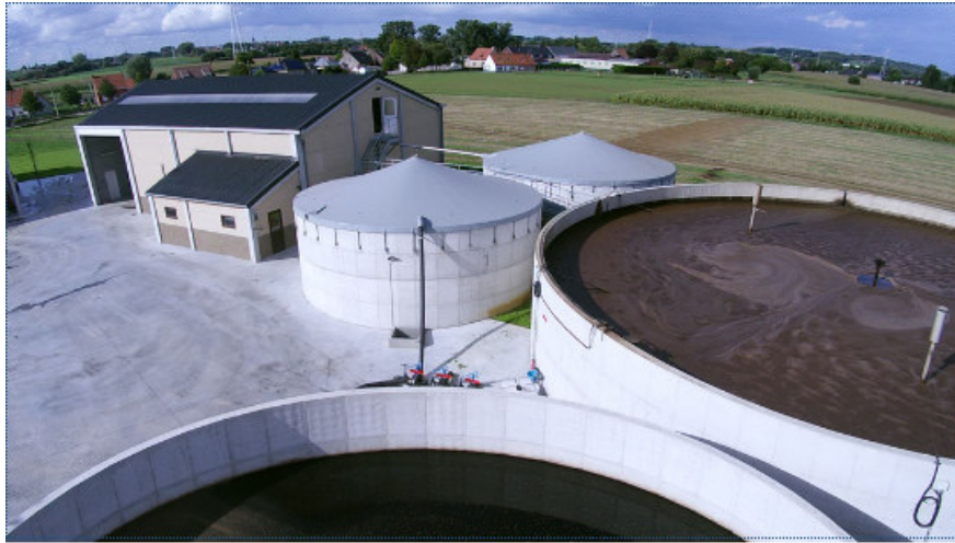
Abbildung 59: Beispiel einer Anlage zur biologischen Reinigung
