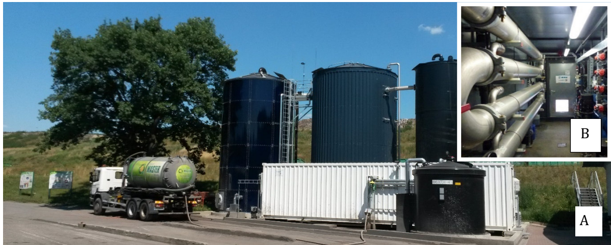
Abbildung 61: Membranbioreaktor mit Ultrafiltration
