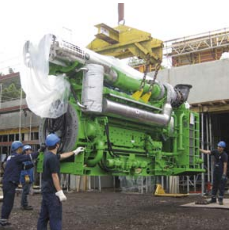
Stadtwerk im Bau: Das erste BHKW-Modul des ersten Kraftwerksprojekts der Ahrtal-Werke wird geliefert.
