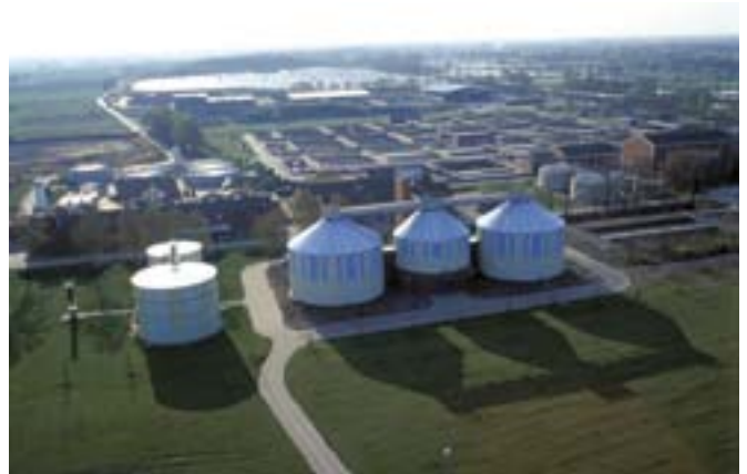
Luftbild der Kläranlage Braunschweig mit ihren Faultürmen. Die Kläranlage versorgt sich selbst mit Strom. Sie nutzt dazu das Verfahren Water2Energy.
