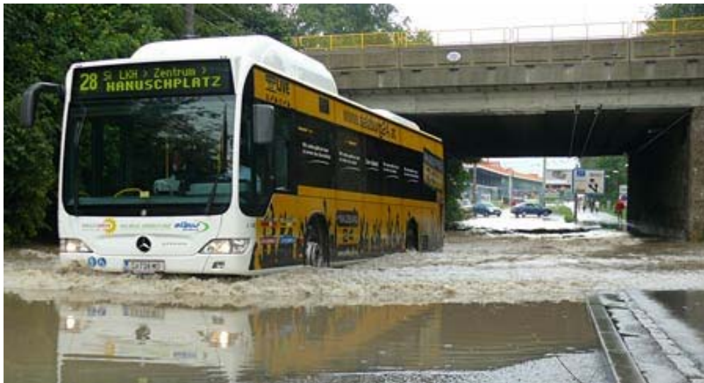
Abb. 5-31 Überflutete Unterführung ohne ausreichenden Abfluss (Aktivnews 2009)
