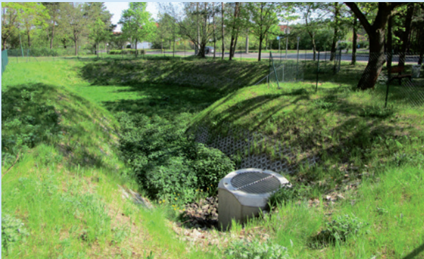
Versickerungsmulde im Eberswalder Brand Viertel
