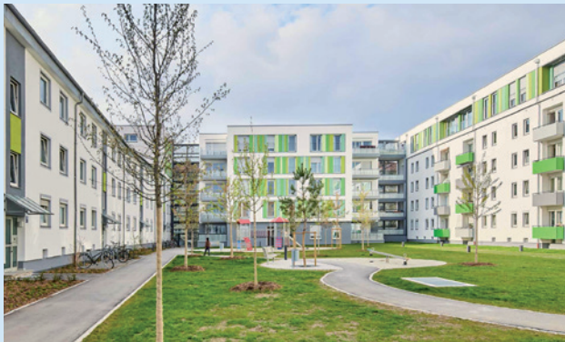
Innovatives Lärmschutzkonzept am Mittleren Ring
