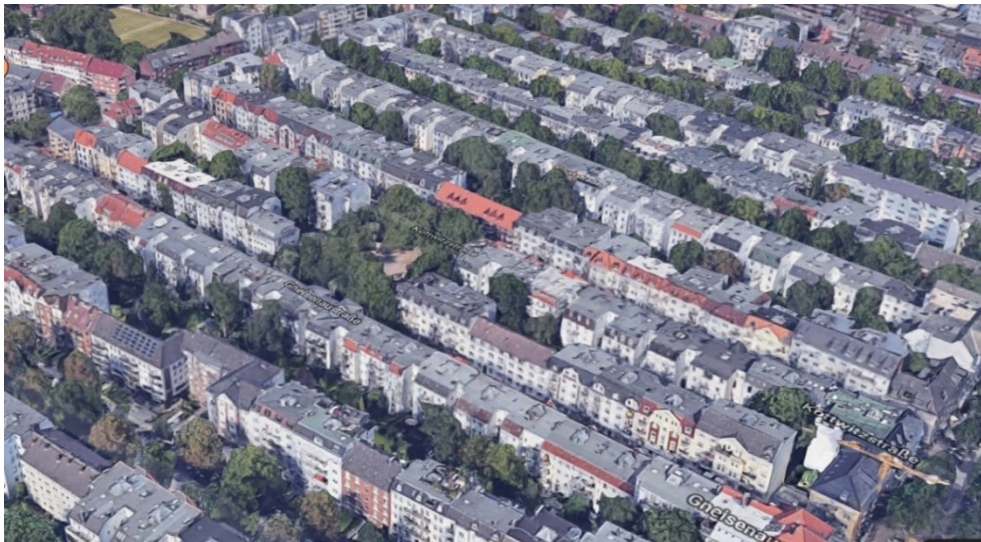
Abbildung 79: Luftaufnahme der Gebäude im Modellgebiet
