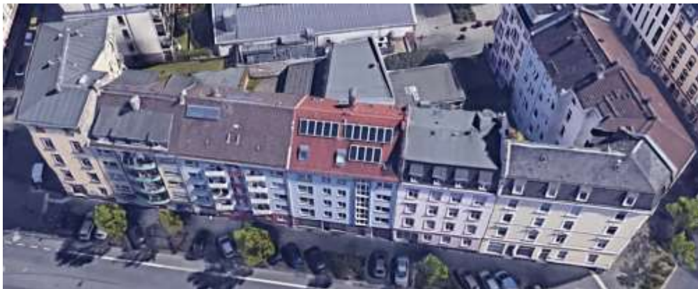
Abbildung 98: Ansicht Blockrandbebauung Bestandsgebäude
