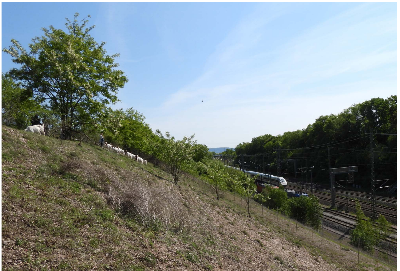
Abb. 27: Böschungspflege durch Ziegenbeweidung – Quelle: Stadt Erfurt/Projektteam Innerstädtische Bahntrassen InBa
