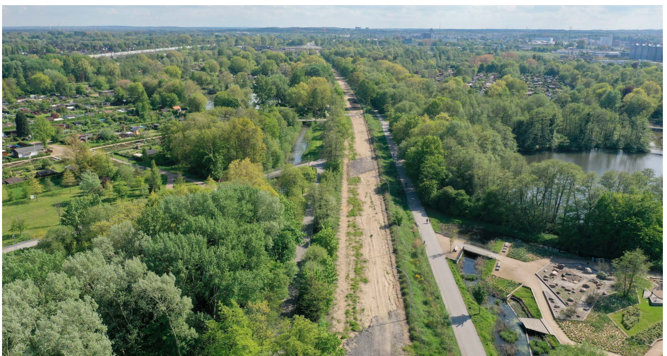
Abb. 38: Rückbau der alten Trasse der Wilhelmsburger Reichsstraße im Inselepark in Hamburg Quelle: Bezirksamt Hamburg-Mitte, Stefan Melchior
