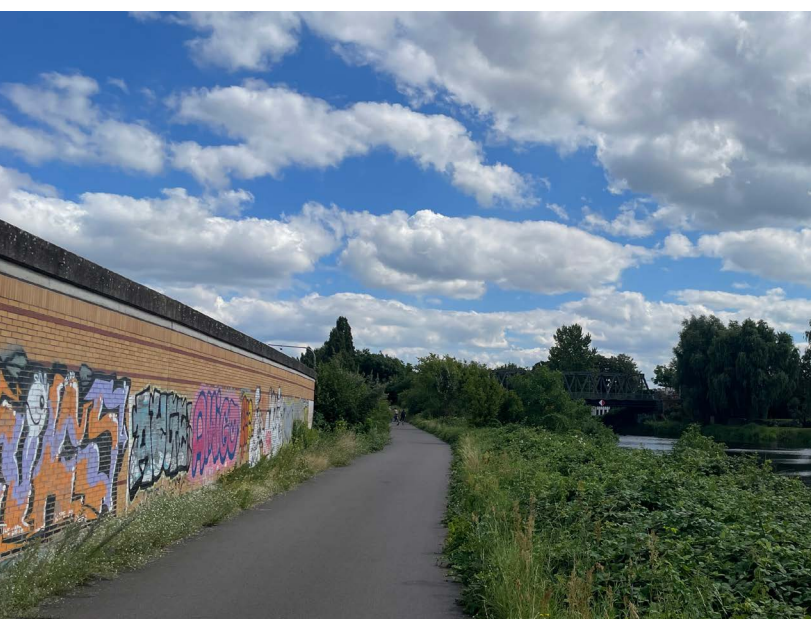
Abb. 29: Betriebsweg der A 113 zwischen Lärmschutzwand und Teltowkanal in Berlin – Quelle: bgmr Landschaftsarchitekten
