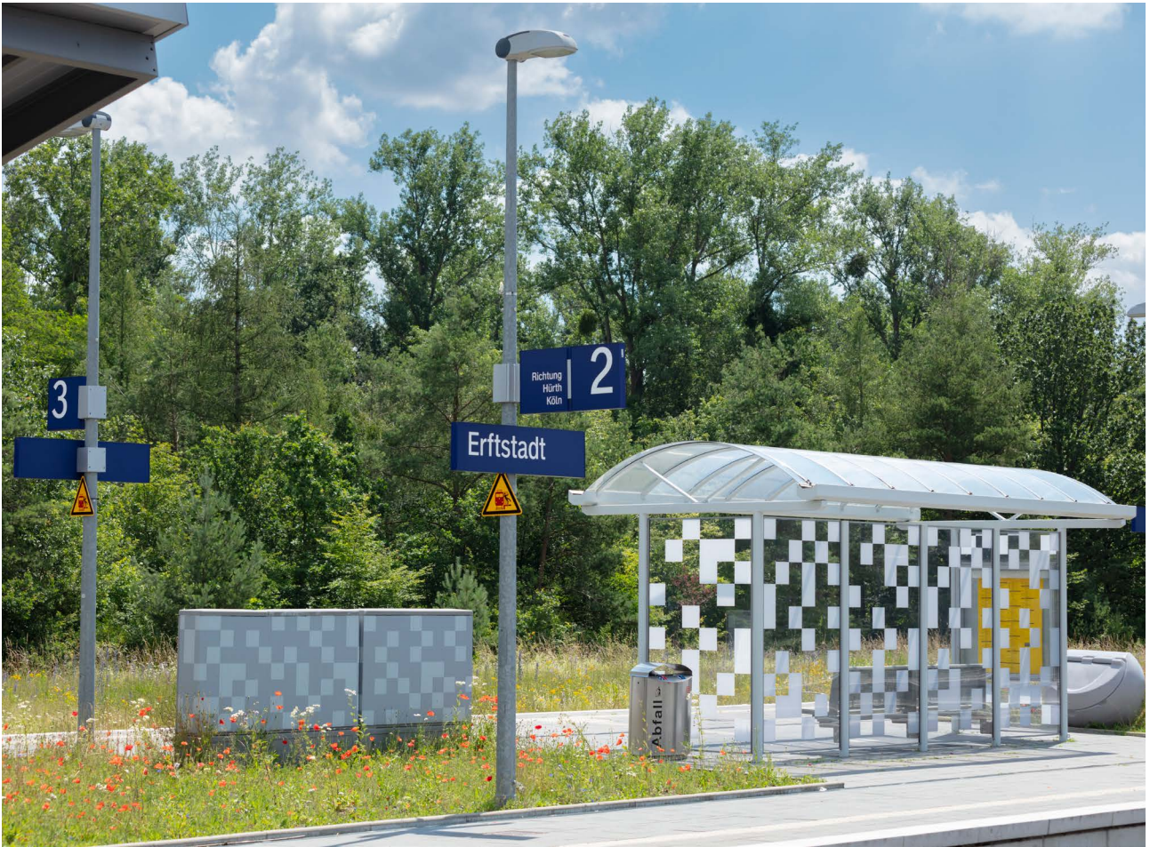
Abb. 21: Neu gestaltetes Wetterschutzhaus und Wildblumenwiese auf dem Bahnsteig in Erftstadt Quelle: Deutsche Bahn AG/Axel Hartmann Fotografie
