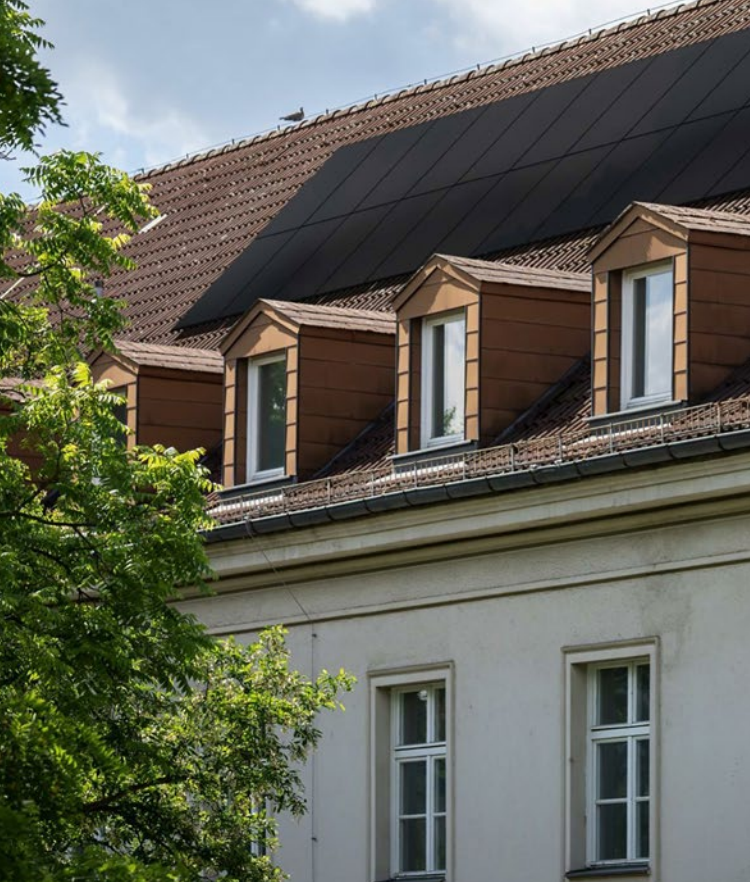
Foto: Planung PV-Anlagen auf dem Dach, Quelle: bmb Generalplanungsgesellschaft Berlin Skizze: Dachansicht PV-Anlage, Quelle: Hofmann Krecké Architekten PartGmbB
