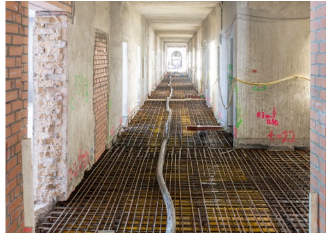
Baustellenfoto Flur, Quelle: Andreas Meichsner
