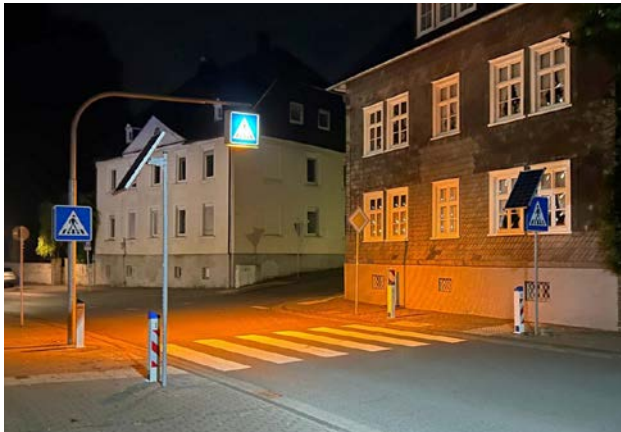
Abbildung 42: Beleuchteter Zebrastreifen mit Laser- und LED-Technik · Quelle: Blömen VuS
