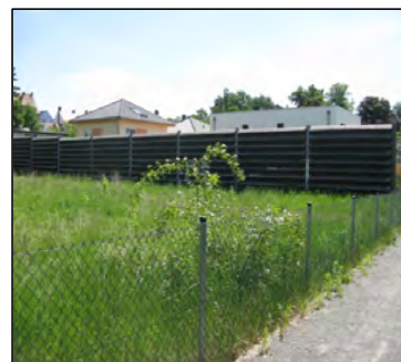
vorhandene Lärmschutzwand am Knoten Essener- / Delitzscher Straße
