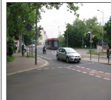
Sanierter Abschnitt am Coppiplatz
