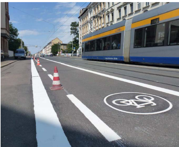
Abb 21: Begleitung der Markierungsarbeiten in der Georg-Schumann-Straße
