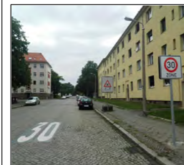
Viertelsweg: Realisierung Tempo-30-Zone
