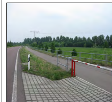
Abschnitt ohne Lärmschutz
