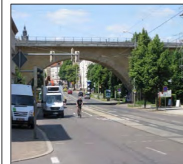
Viadukt ohne Schallschutzwand
