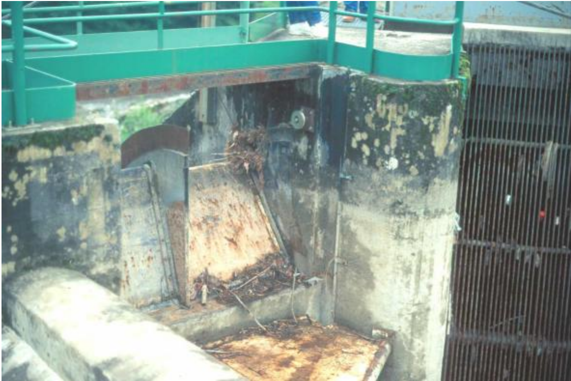
Abb. 6.19: Der Leerschuss des Wasserkraftwerkes Soeix am Gave d'Aspe (Frankreich) unmittelbar oberhalb des Einlaufrechens wurde erfolgreich zu einem Bypass für Lachssmolts umfunktioniert (Ansicht bei abgelassenem Oberwassergraben)
