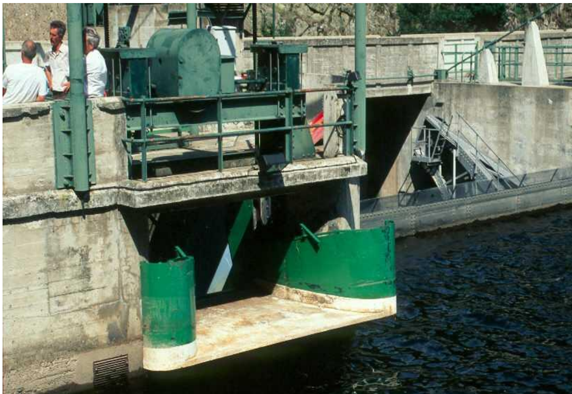
Abb. A.4: Bypass-Düse für atlantische Lachssmolts mit Beleuchtung zur Verbesserung der Attraktionswirkung: Der Einlauf des Bypasses am Staudamm Poutès im Allier ist so geformt, dass möglichst geringe Turbulenzen entstehen und die Strömung stetig beschleunigt wird. Der Bypass ist höhenverstellbar und kann so an wechselnde Oberwasserstände angepasst sowie außerhalb der Betriebszeiten über die Wasseroberfläche emporgehoben werden.
