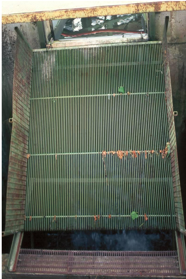
Abb. 5.29: Tiroler Wehr für Abstiegskontrollen im Bypass des Kraftwerks Halsou an der Nive (Frankreich); Einlauf oben, Spülrinne am unteren Bildrand
