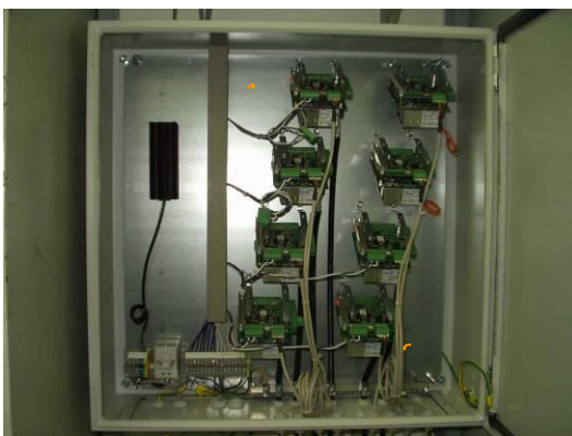
Abb. 5.84: Deutsche Weiterentwicklung der HDX-Technologie; rechts: kompakter Schaltschrank mit 8 Lesegeräten; links: dazu gehöriger Schaltschrank mit Transformator und PC sowie Überspannungsschutz und Sicherungen
