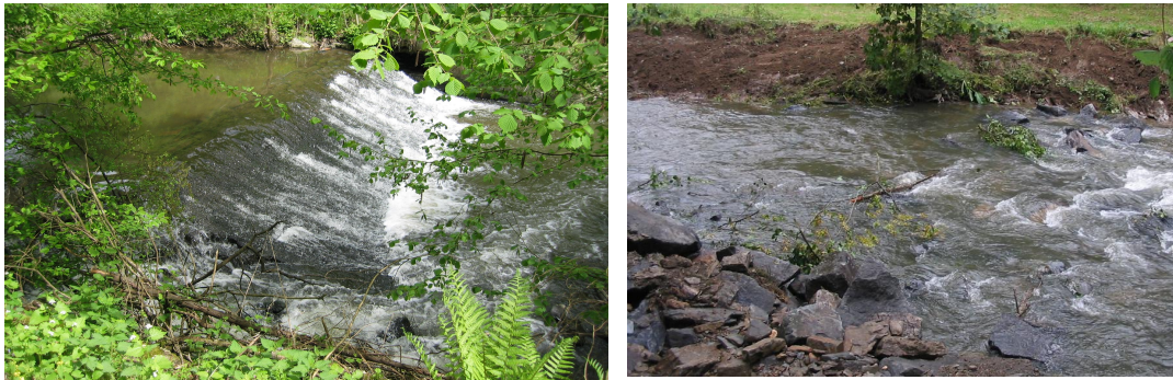
Abb. A.1: Wehr am Saynbach (Rheinland – Pfalz) vor und nach dem Rückbau
