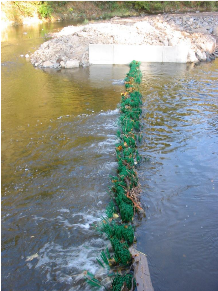
Abb. A.7: Aufwandersperre mit Borsten an der Mündung eines Unterwasserkanals (Our)
