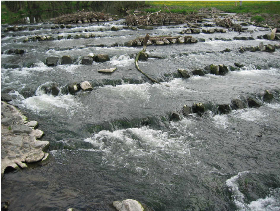
Abb. A.37: Fischrampe mit nicht überströmten Schwellen, an denen sich Geschwemmsel verfängt.
