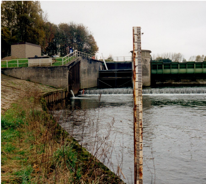
Abb. C. 9: Zusätzliche Wasserkraftanlage zur energetischen Nutzung des Mindestabflusses an der Wehranlage Hengsen/Ruhr. Der Auslauf der Turbine mündet unmittelbar unterhalb der letzten Wehrschwelle in das Gewässer.
