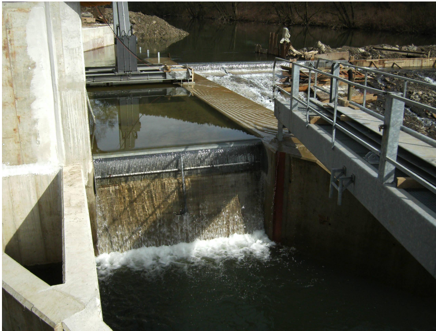
Abb. B. 11: Blick auf das eigentliche, überströmte Kraftwerk. Der Rechenreiniger befördert das Rechengut in den Kanal über der Turbine und es wird durch Öffnen der Klappe abgespült. Dieser Kanal fungiert gleichzeitig als oberflächennaher Bypass.
