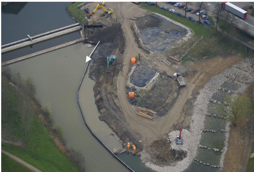
Abb. A.15: Fischaufstiegsanlage Hambeek in Roermond/NL während des Baus. Der Einstieg wurde gezielt neben dem Wehr angeordnet.
