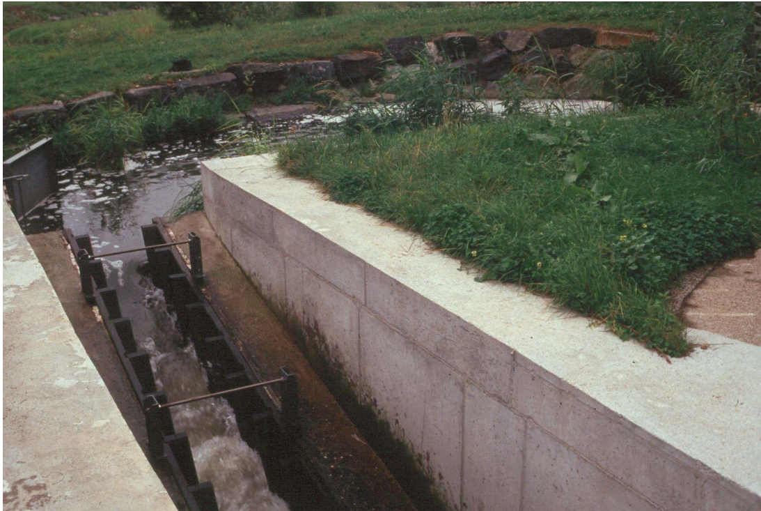
Abb. A.30: Denil-Pass am Kraftwerk Unkelmühle (Sieg, NRW) als Ergänzung zu der naturnahen Fischaufstiegsanlage am Wehr.
