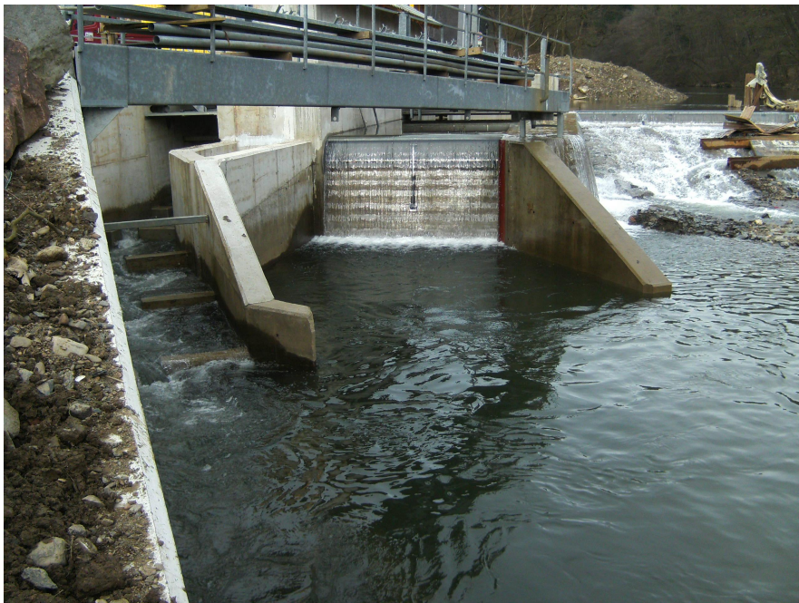
Abb. B. 10: Blick von Unterwasser auf die WKA: links die Fischaufstiegsanlage (Vertical Slot), mittig der Auslauf der Turbine, darüber die Spülklappe für Rechengut und absteigende Fische, rechts das Wehr.
