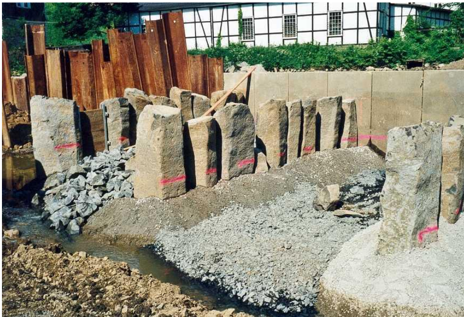
Abb. A.21: Raugerinne mit Beckenstruktur im Bau- Riegel aus großen Wasserbausteinen, raue Sohle mit filterstabilem Aufbau (Betzdorf/Sieg, Rheinland-Pfalz).
