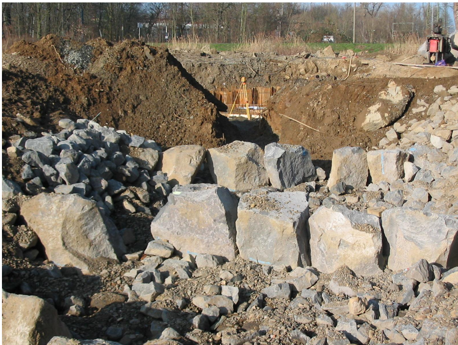
Abb. A.35: Gestaltung der rauen Sohle innerhalb eines mit Steinblöcken begrenzten Beckens während der Bauzeit.
