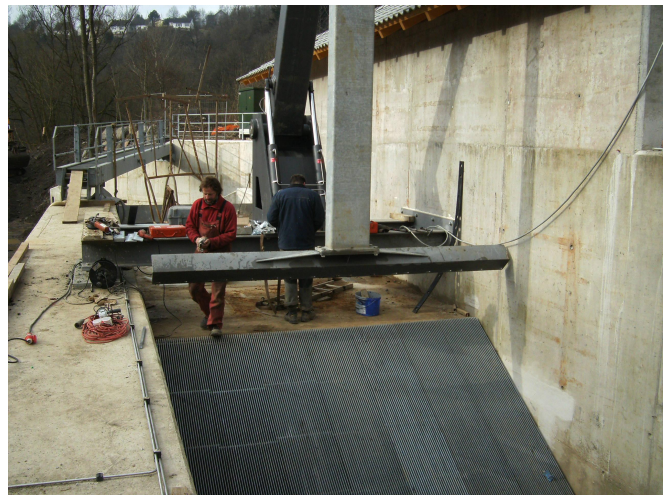
Abb. B. 14: Montage des 15 mm – Rechens und der Rechenreinigungsmaschine.
