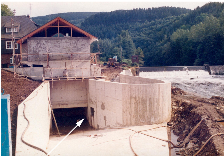
Abb. A.32: Unterwasserseitige Ansicht einer im Bau befindlichen Wasserkraftanlage an der Sieg (Rheinland-Pfalz, 1985). Rechts ist neben dem Saugrohraustritt der Einstieg in die Fischschleuse erkennbar. Die Schleuse ist parallel zum Krafthaus angeordnet und mündet in den Oberwasserkanal. Funktionskontrollen zu dieser Anlage liegen bisher nicht vor.
