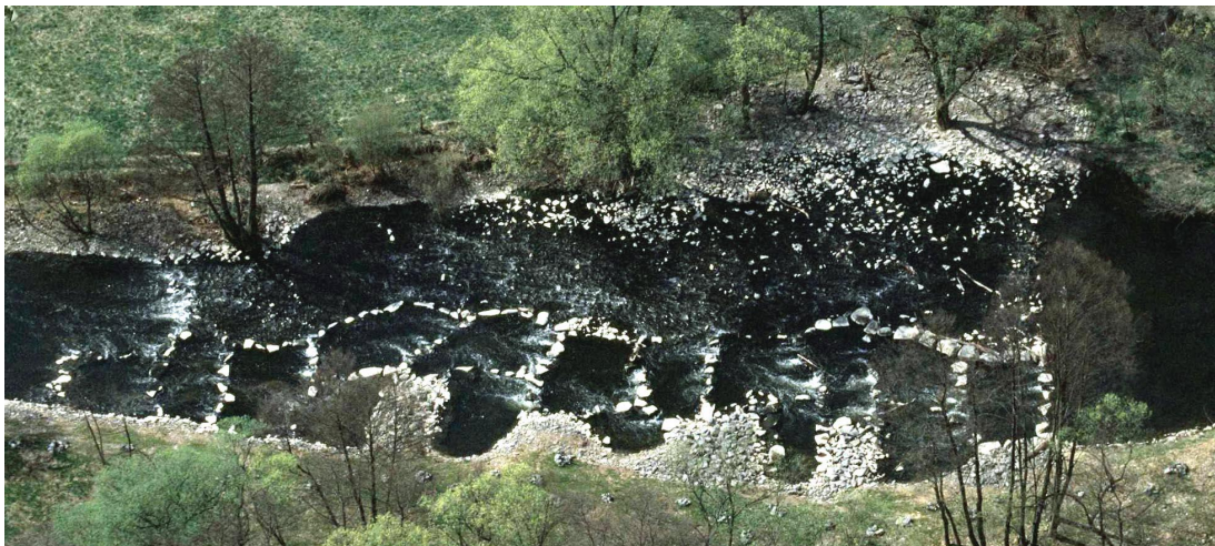
Abb. A.25: Geteiltes Raugerinne mit Beckenstruktur und flächigem Gerinne (Elbbach, Hessen).
