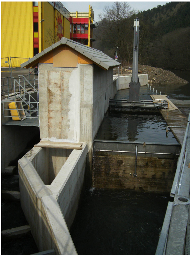
Abb. B. 12: Links die FAA, die landseitig um das Kraftwerk führt. In der Mitte liegt der Zugangsschacht, rechts das überströmte Krafthaus.
