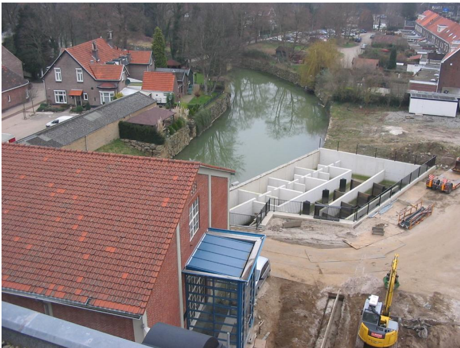
Abb. B. 16: Vertical Slot Pass an der WKA ECI-Centrale in Roermond NL / Rur
