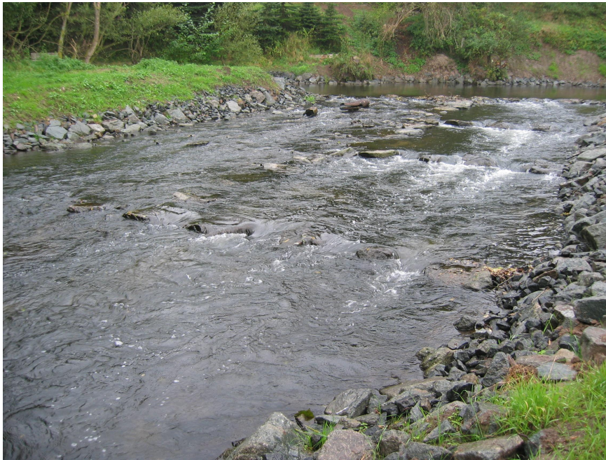
Abb. A.26: Geteiltes Raugerinne mit Beckenstruktur und flächigem Gerinne (Hasel, Thüringen), rechts im Bild ist die Beckenstruktur zu erkennen.
