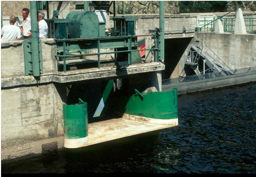
Abb. B. 20: Bypass-Düse für atlantische Lachssmolts mit Beleuchtung zur Verbesserung der Attraktionswirkung: Der Einlauf des Bypasses am Staudamm Poutès im Allier ist so geformt, dass möglichst geringe Turbulenzen entstehen und die Strömung stetig beschleunigt wird. Der Bypass ist höhenverstellbar und kann so an wechselnde Oberwasserstände angepasst sowie außerhalb der Betriebszeiten über die Wasseroberfläche emporgehoben werden.
