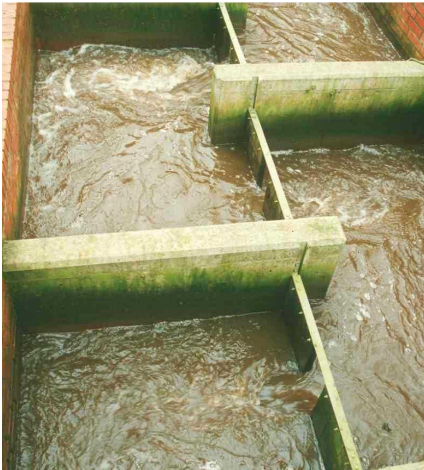
Abb. A.29: Kompakte Ausführung eines Schlitzpass ähnlichen Beckenpasses. Die hydraulische Berechnung kann nicht standardmäßig erfolgen (Heiligenrode, Brandenburg).
