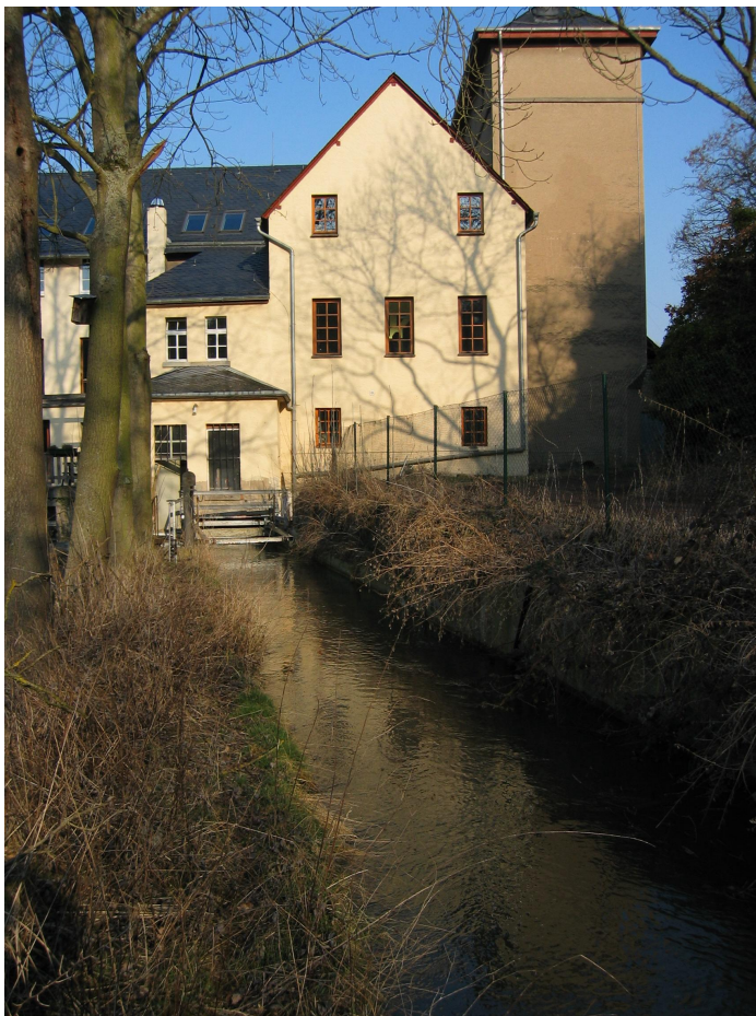
Abb. B. 4: Gesamtansicht Oberwasserkanal mit Rechenanlage
