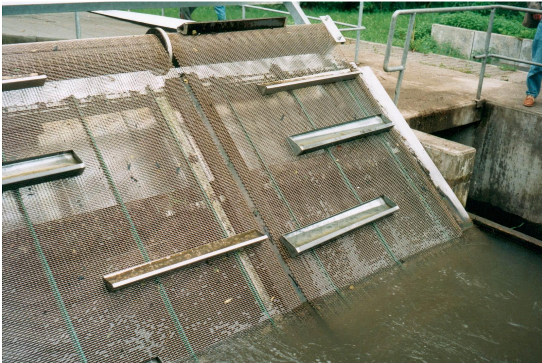
Abb. B. 19: Rollrechen mit Transporttrögen (Hadamard/ Elbbach, Hessen)
