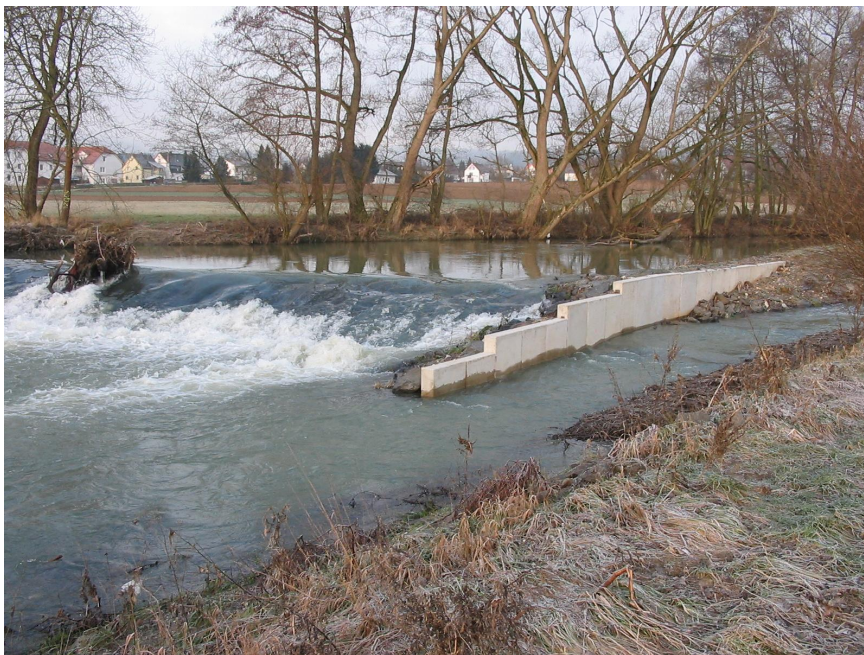
Abb. A.12: Umgehungsgerinne am Elbbach (Hessen): Der Einstieg befindet sich unmittelbar neben dem Wehr
