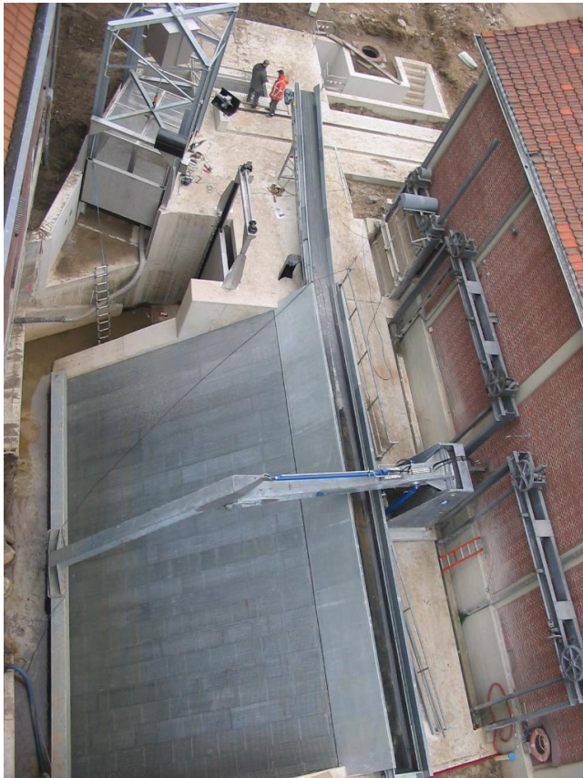
Abb. B. 17: 10 mm - Rechenanlage in Roermond mit Rechenreiniger, Querförderer für das Rechengut, Spülschütz sowie Fang- und Kontrollstation für die FAA
