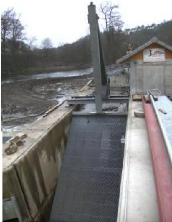
Abb. B. 13: Der flach geneigte 15 mm – Rechen und die Rechenreinigungsmaschine vor der Flutung der Anlage.
