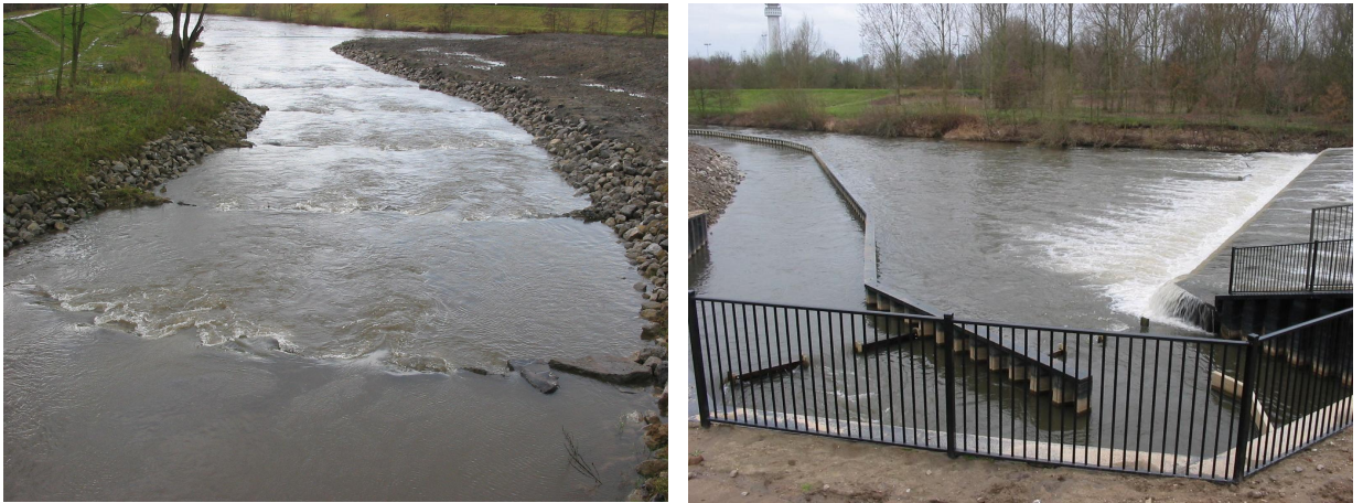
Abb. B. 15: Umgehungsgerinne Hambeek mit Riegelstruktur, rechts der optimierte Einstieg unmittelbar neben dem Wehr
