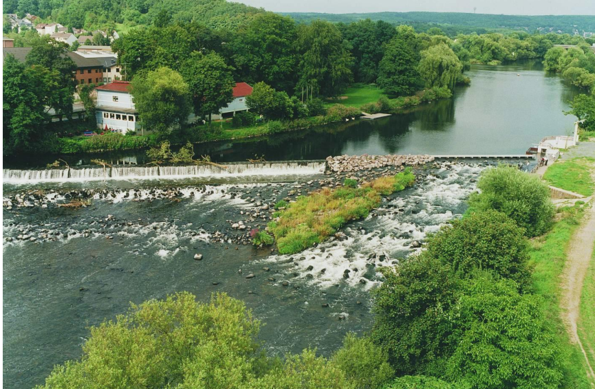
Abb. A.23 Fischaufstiegsanlage (Buisdorf /Sieg, NRW) Raugerinne mit einer Mischung aus Querriegeln und Störsteinen und seitlicher Verschneidung, die jedoch nicht gut passierbar war. Daher wurde in diesem Bereich ein Vertical-Slot-Pass zusätzlich eingebaut (Quelle: Städler).
