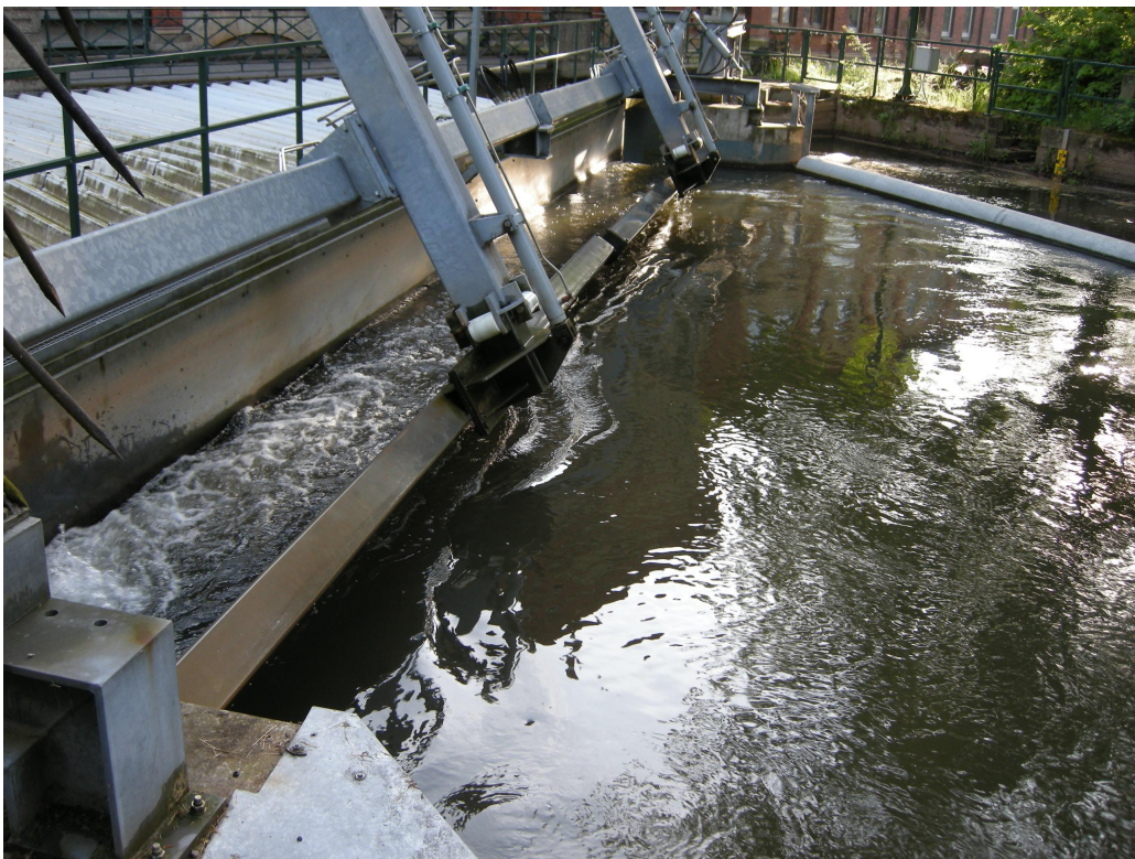
Abb. 2.13: Rechen mit Rechenreiniger Banteln
