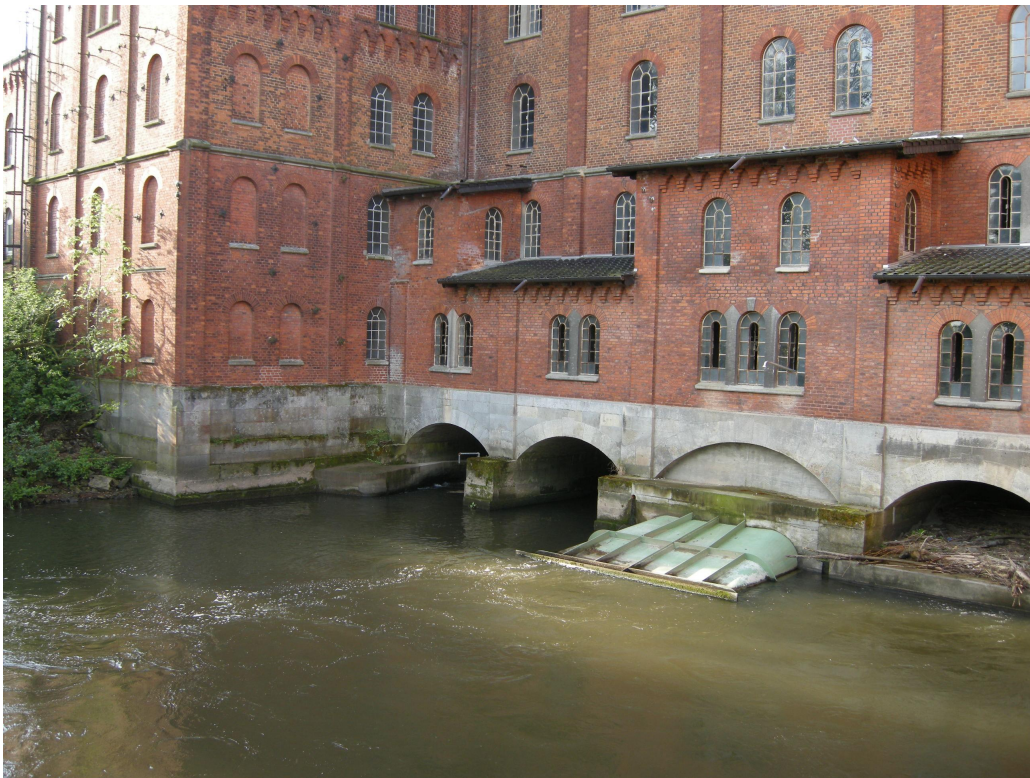
Abb. 2.12: Auslauf der Wasserkraftanlage Banteln
