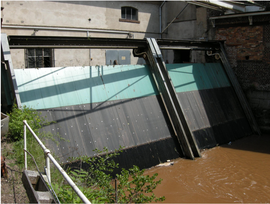
Abb. 2.19: Rechen mit Rechenreiniger Freden
