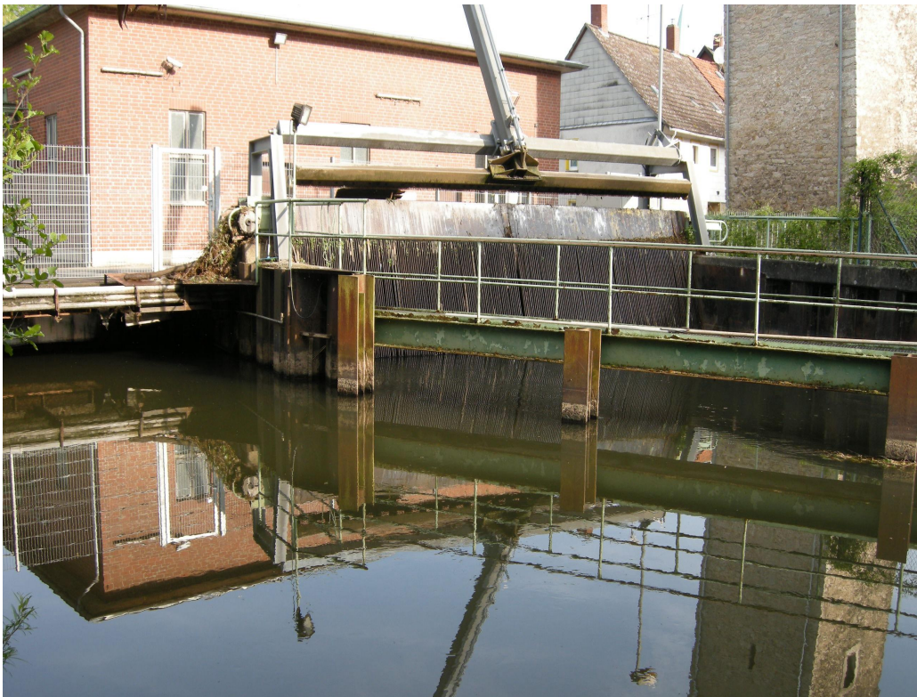
Abb. 2.9: Rechen mit Rechenreiniger Wasserkraftanlage Gronau I
