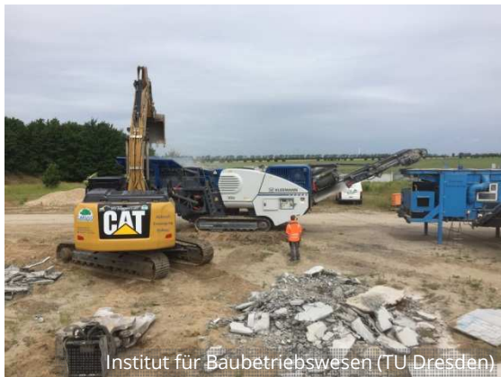
Institut für Baubetriebswesen (TU Dresden) Aufgabe des C 3 -Materials in den Backenbrecher
