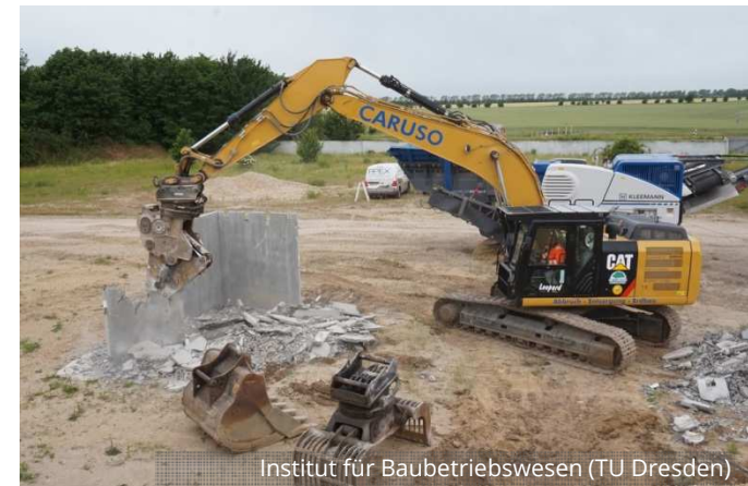
Totalabbruch beider Demonstratoren
