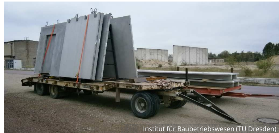
C 3 -Wände und -Decken Transport zur Montage
