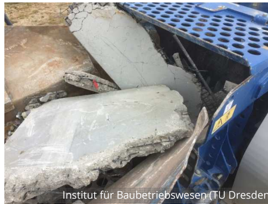
Institut für Baubetriebswesen (TU Dresden) C 3 -Material im Backenbrecher
