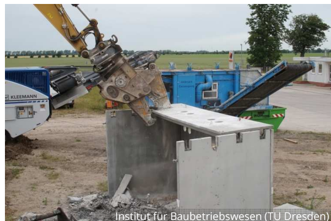
Abbruchverfahren „Pressschneiden“
