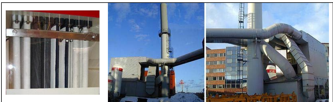
Bild 4.10: Gewebefiltereinheiten; Innenansicht (l.) und Außenansicht (m., r.) [237, HUT, 2003]
