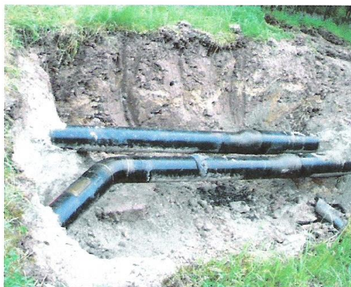
Трубопровод откопан для измерения толщины стенки
