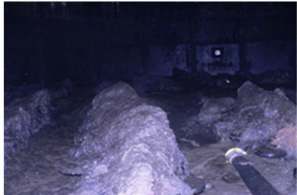
Boden des alten Schlammvorlagebehälters mit sedimentiertem MAP
