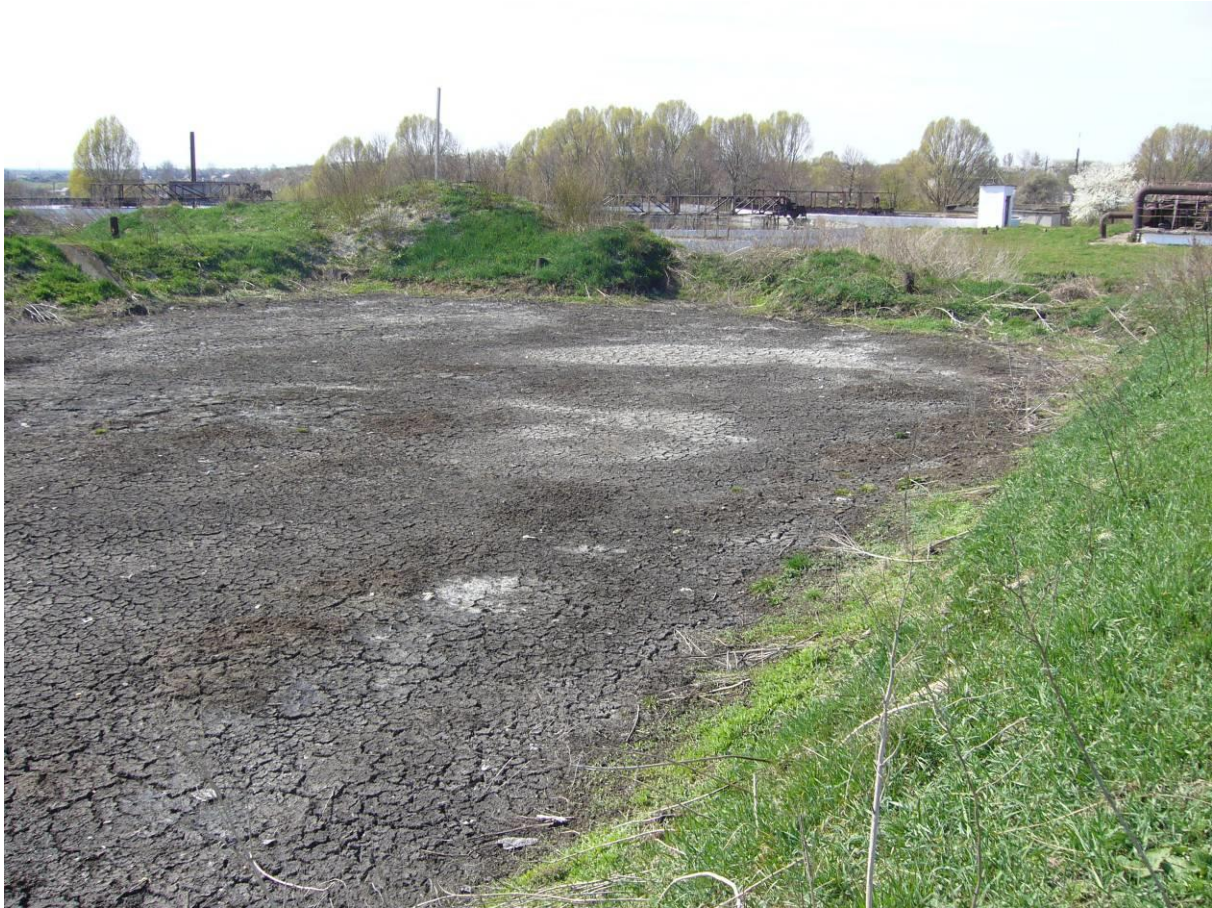
Rysunek 14 Poletka osadowe w oczyszczalniach ścieków w Nowowołyńsku
