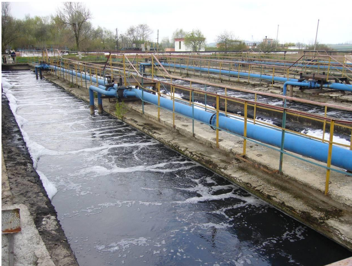
Rysunek 16 Komora napowietrzania w OŚ w Czerwonogrodzie
