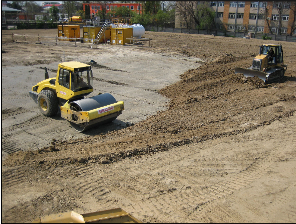
Foto 8: Wiedereinbau von biologisch behandeltem sanierten Boden (Quelle: Züblin)
