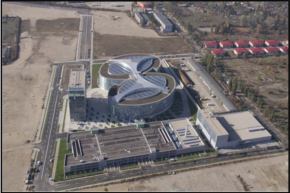
Abb. 6: PETROM-Zentrale in Bukarest (Quelle: Züblin)
