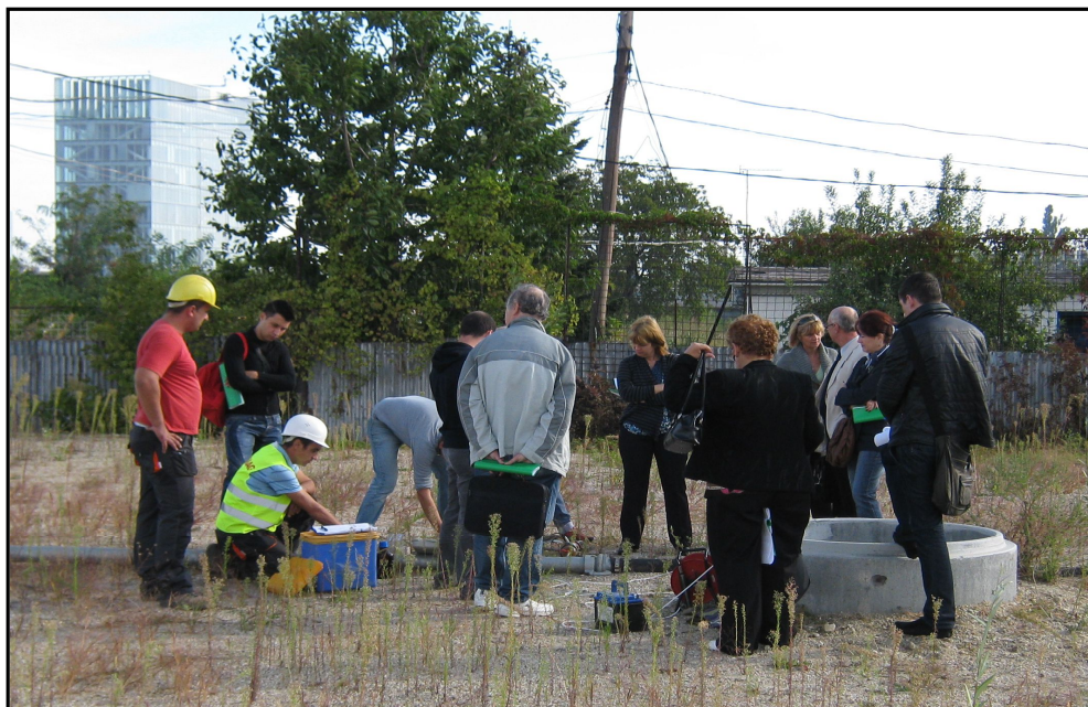
Foto 13: Grundwasserprobenahme im Beisein der Behörden (Quelle: Züblin)
