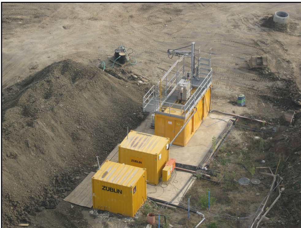
Foto 11: Anlage zur Ölabsaugung (zwei Container) und Übergabestation (Tank für Bereitstellung der Phase & Verladeeinheit) (Quelle: Züblin)
