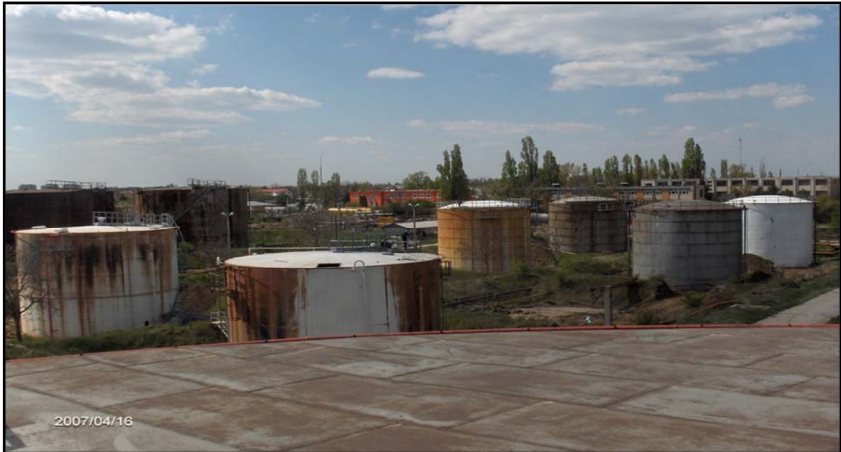
Abb. 2: Tanklager vor dem Rückbau (Quelle: Züblin)
