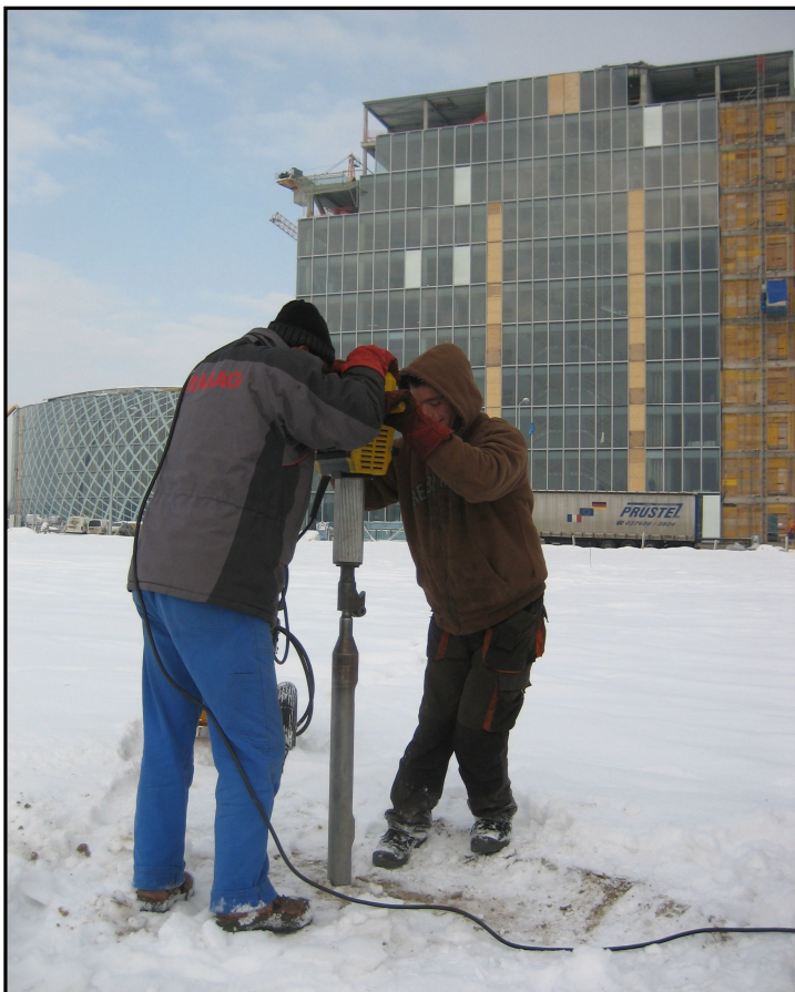
Foto 9: Überprüfung des Sanierungserfolgs nach Wiedereinbau des sanierten Bodens (Quelle: Züblin)
