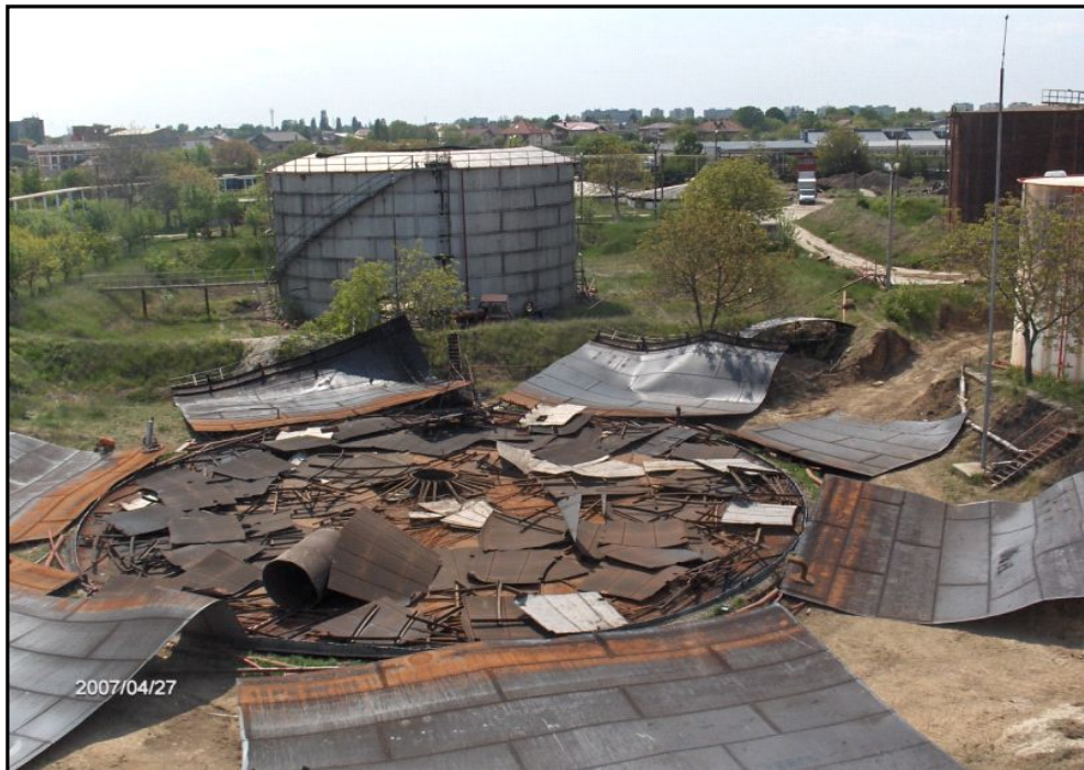
Foto 5: Abbrucharbeiten Tanks – Tankhöfe wurden nach Bodensanierung verfüllt (Quelle: Züblin)
