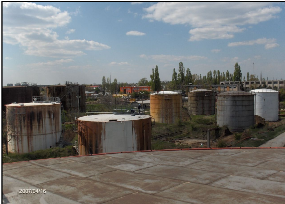
Foto 3: Tanklager vor dem Rückbau (Quelle: Züblin)
