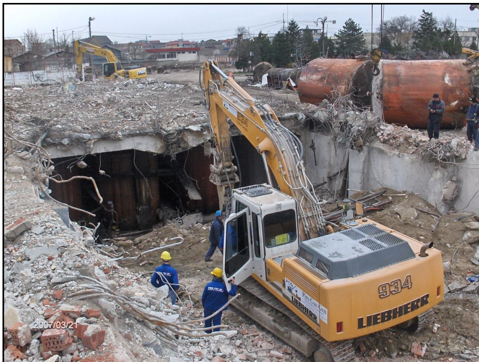
Foto 4: Abbrucharbeiten (Quelle: Züblin)
