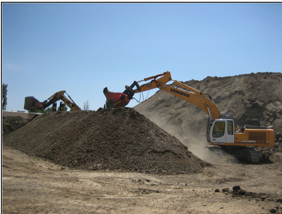
Foto 7: Biologische Bodenbehandlung – Bearbeitung / Durchmischung der Mieten (Quelle: Züblin)
