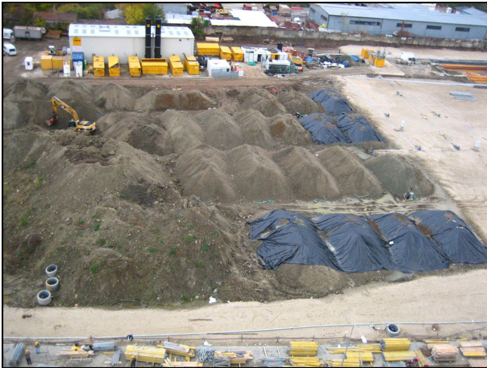
Foto 6: Biologische Bodenbehandlung – Bodenmieten (Quelle: Züblin)
