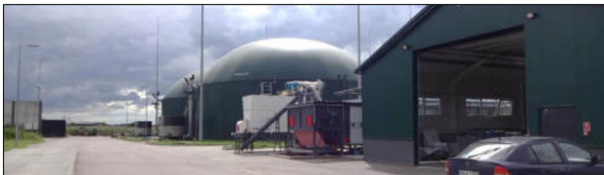
Abb. 82: Biogasanlage bei Stary Kornin (Gemeinde Dubicze Cerkiewne)
