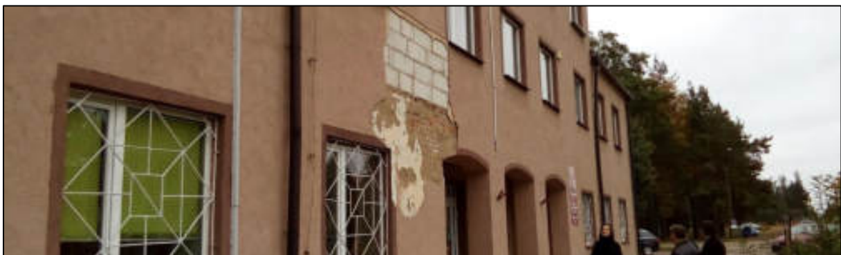
Abb. 117: Ungedämmte Gebäudehülle einer kommunalen Liegenschaft
