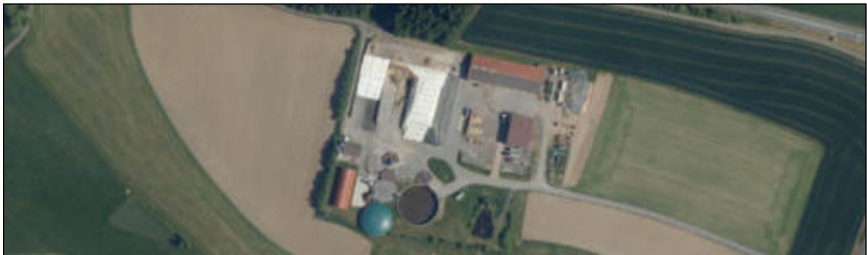
Abb. 187: Die landwirtschaftliche Biogasanlage bei Meierhof im Luftbild
