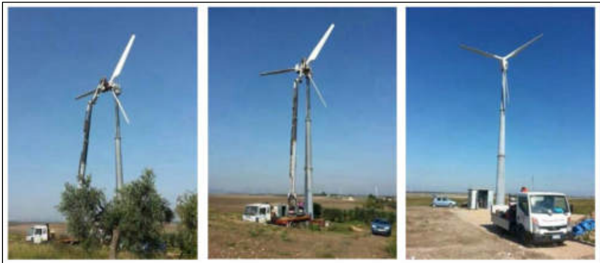
Abb. 88: Aufbau einer Kleinwindkraftanlage in Italien
