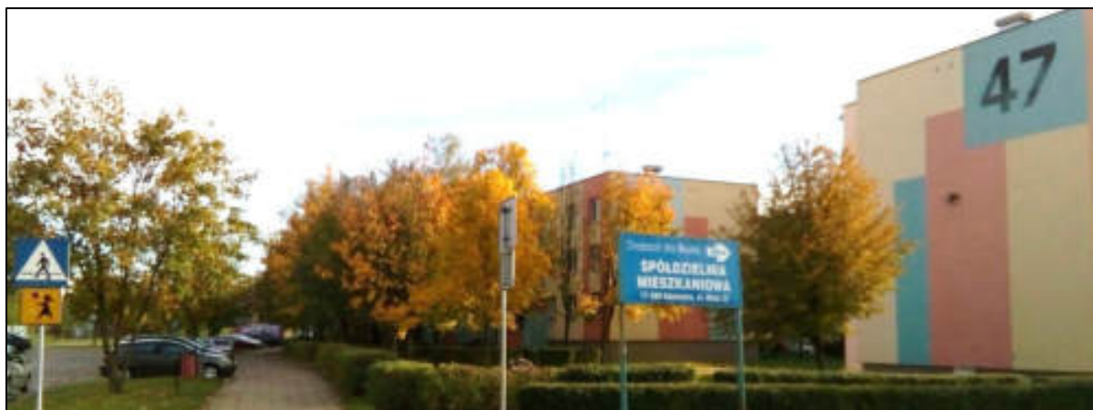
Abb. 9: Platten- und Geschosswohnungsbau in Hajnówka
