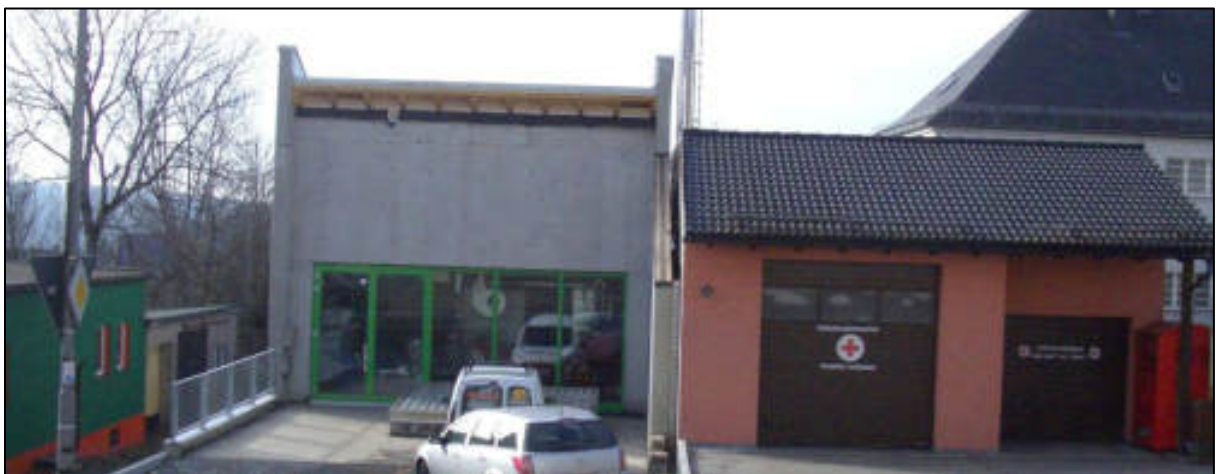
Abb. 186: Das gläserne Heizwerk in Nordhalben bei Baufertigstellung
