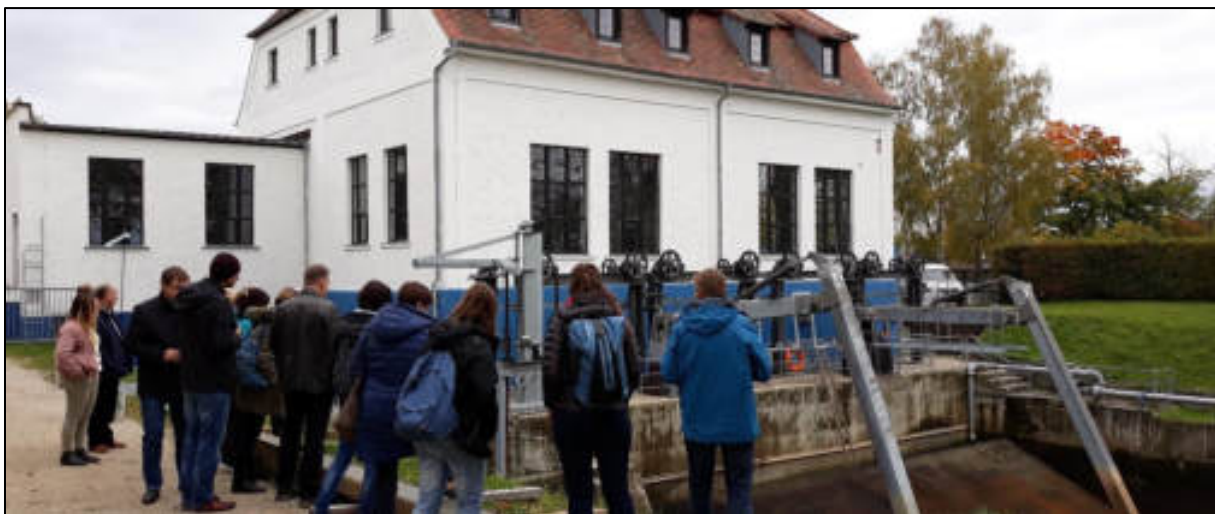
Abb. 83: Ein Wasserkraftwerk bei Erlangen (Deutschland)
