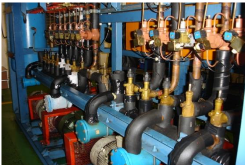
Kälteanlage eines Supermarktes
