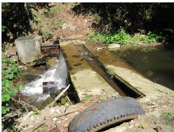
Die Gemeinde Văliug benötigt dringend eine zeitgemäße Wasserfassung (Foto: COPLAN AG)
