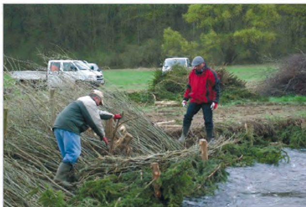
Фото 16: У результаті гілки повинні лежати впритул і покривати весь схил. Далі нижні кінці гілок притискають до підніжжя схилу живою фашиною. (Фото: A. Stowasser)
