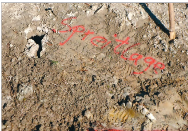
Фото 13: Перед укладанням хмизу поверхню схилу необхідно вирівняти. Гілки повинні рівно лежати на оголеній поверхні ґрунту. (Фото: A. Stowasser)
