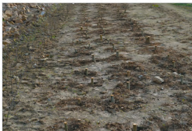
Фото 4: Живці встромляються у ґрунт під різними кутами із розподілом на схилі. (Фото: A. Stowasser)
