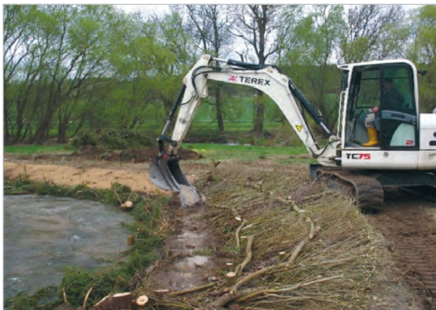
Фото 19: Вкривання хмизу невеликим шаром землі за замулення створює для гілок контакт із ґрунтом та дає їм можливість проростати. (Фото: A. Stowasser)
