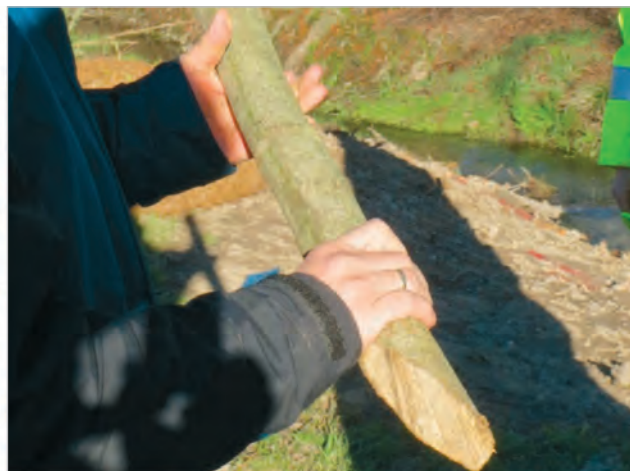
Фото 2: Завжди слід звертати увагу на напрямок росту живців. На нижньому кінці їх слід зрізати під кутом. (Фото: A. Stowasser)
