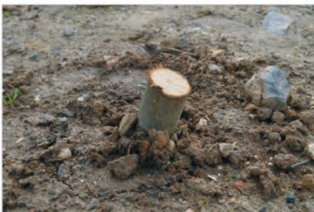
Фото 3: Більшу частину живця потрібно встромити у схил. Назовні повинні виступати максимум 5 см, за необхідності гладко обріжте верхній кінець ще раз. (Фото: A. Stowasser)
