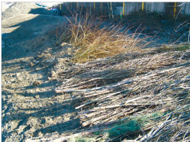
Фото 25: З екологічних міркувань вербовий матеріал для облаштування слід заготовляти якомога ближче до проведення робіт. (Фото: A. Stowasser)
