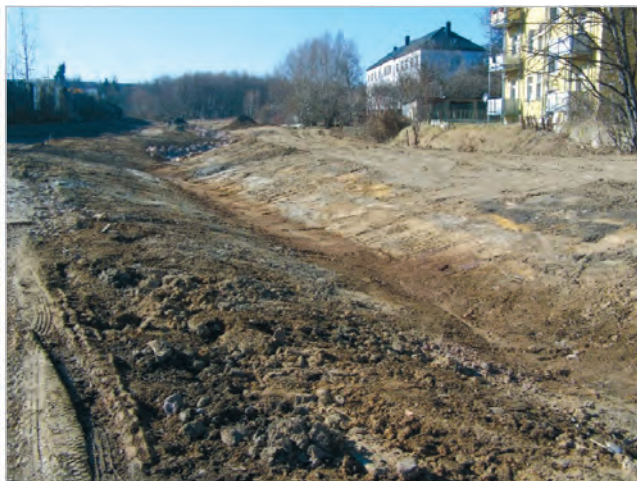
Фото 26: Під час профілювання русла або берегового схилу водотоку необхідно передбачити фашинну траншею, а схил слід зробити якомога пологішим. (Фото: A. Stowasser)
