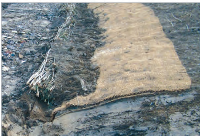
Фото 27: Захисна мата – це нижній шар конструкції. Вона повинна бути міцно закріплена, щоб її неможливо було вирвати. (Фото: A. Stowasser)
