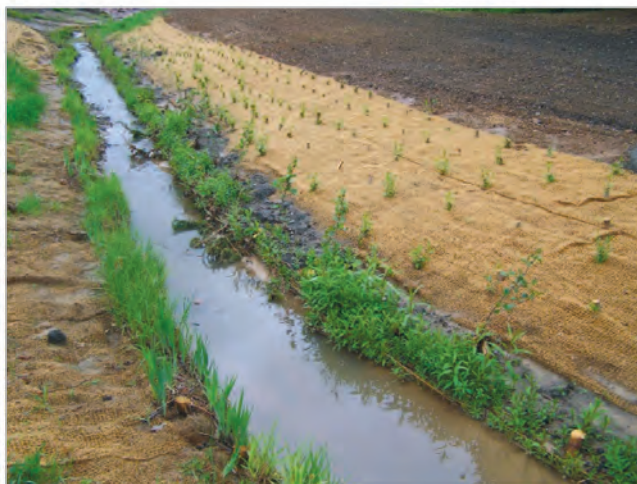
Фото 30: Конструкція захищає схил зразу після завершення облаштування і в міру проростання ефективність підвищується ще більше. (Фото: A. Stowasser)
