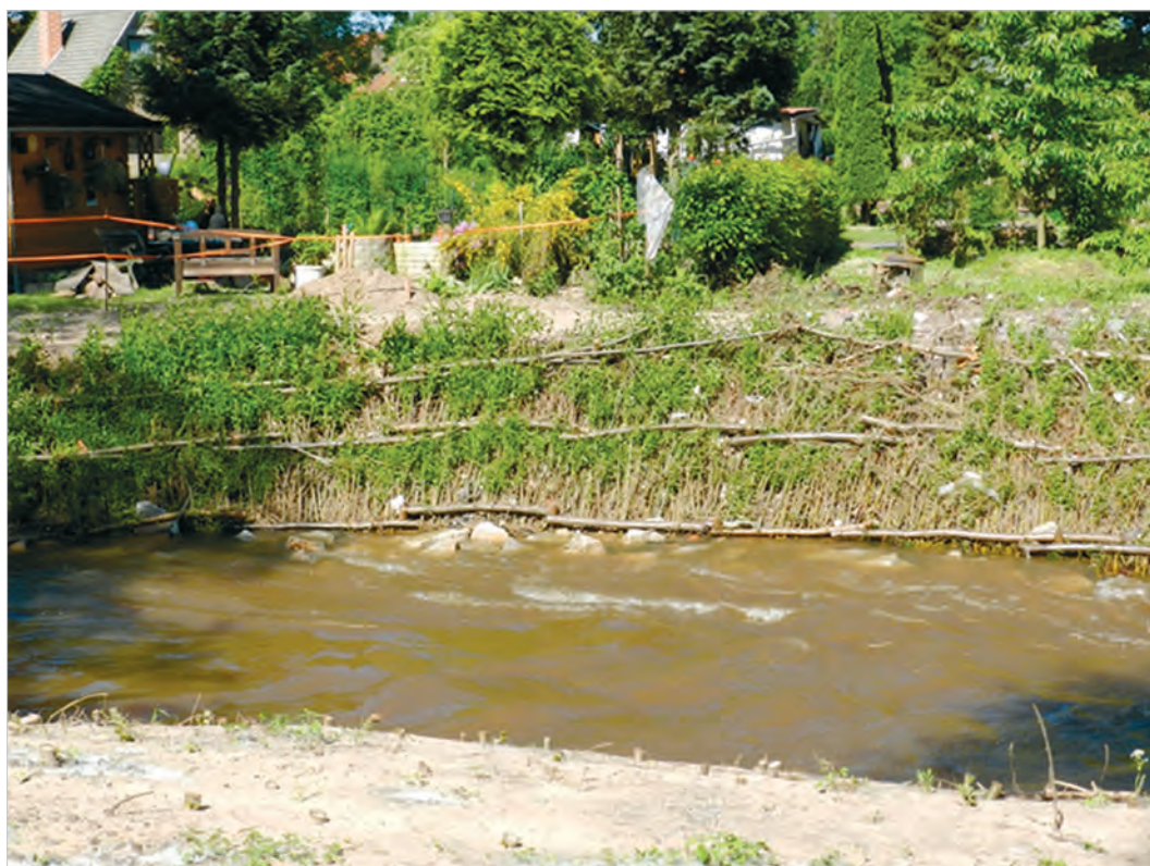
Рисунок 20: Стан схилу, вистеленого вербовим хмизом, 05.06.2013 року о 9:00 год. після проходження двох хвиль паводка 31.05.2013 р. та 03.06.2013 р. (Джерело: М. Dittrich 2013)
