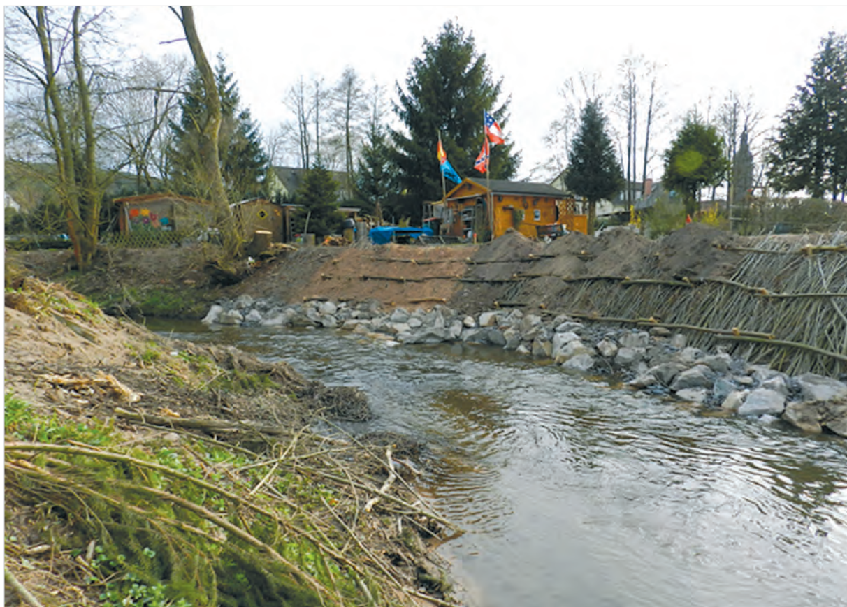
Рисунок 18: Вистилання вербовим хмизом з укріпленням основи схилу в місцевості Лаасдорф, незадовго до завершення 20 квітня 2013 року (Джерело: М. Dittrich 2013)
