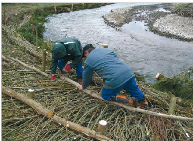
Фото 17: Закріплення гілок у зоні схилу виконується за допомогою перекладин, скріплених дротом. (Фото: A. Stowasser)
