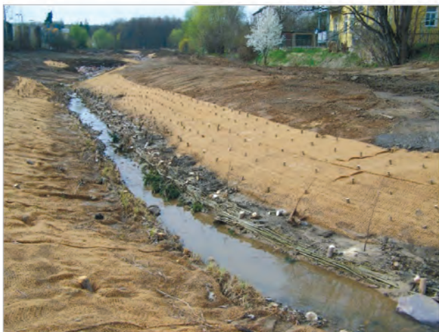
Фото 29: Живі фашини легко прикопати, щоб забезпечити хороший контакт із землею та гарантувати проростання. (Фото: A. Stowasser)
