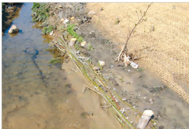
Фото 28: Після цього садять дерева. Прикріплена ними фашина утримує конструкцію біля основи схилу. (Фото: A. Stowasser)
