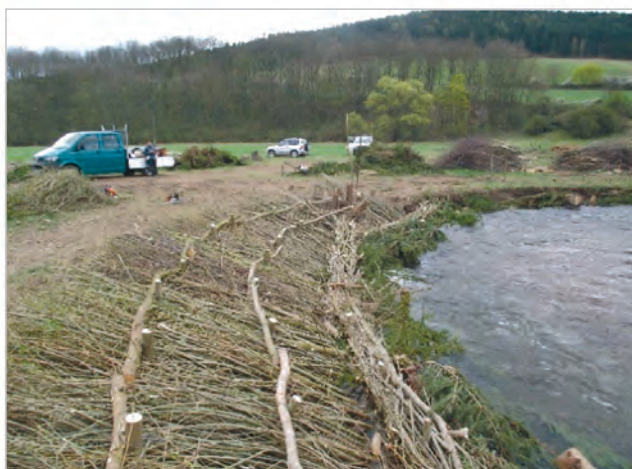
Фото 18: Кілочки забивають ще глибше, щоб притиснути пучок гілок до схилу. В кінці гладко відпиляти кілочки і обрізати кінці гілок, які стирчать над схилом. (Фото: A. Stowasser)
