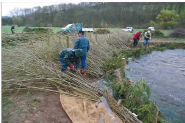
Фото 15: Усі гілки хмизу вкладають на схилі товстим (базальним) кінцем донизу. Нижні кінці повинні розташовуватися нижче середнього рівня води. (Фото: A. Stowasser)
