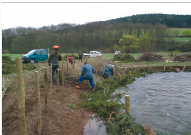
Фото 14: Спочатку необхідно забити кріпильні кілки. Це можна зробити за допомогою екскаватора. (Фото: A. Stowasser)
