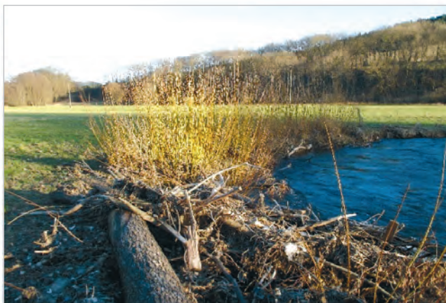
Фото 22: Пророслий хмиз забезпечує дуже хороший захист схилів. Схильні до пошкоджень зони переходу до незахищених ділянок або до інших методів облаштування. Особливу увагу тут потрібно приділити правильному виконанню робіт. (Фото: A. Stowasser)
