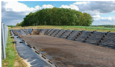
❶ Рис. 4: Земляная лагуна (пленочная лагуна).
