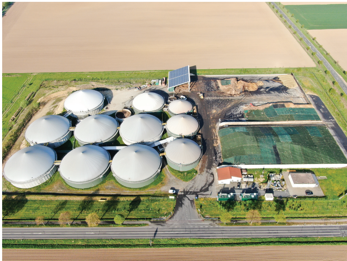
❶ Fig. 3: Instalația de biogaz în Rosdorf
