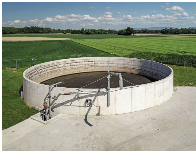
Fig. 5: Rezervor din amestec de beton
