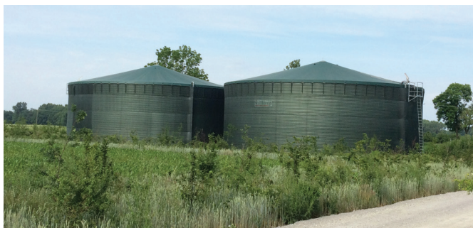
❶ Рис. 7: Резервуар из нержавеющей стали.
