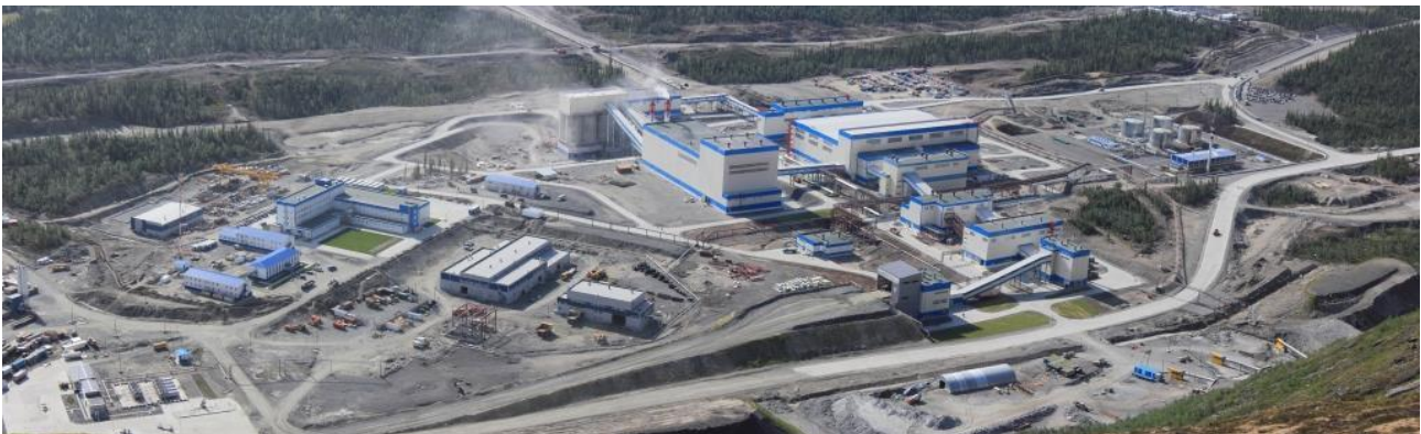
Abbildung 13-4: Anlagen des Oleniy Ruchey Minenkomplexes von NWPC
