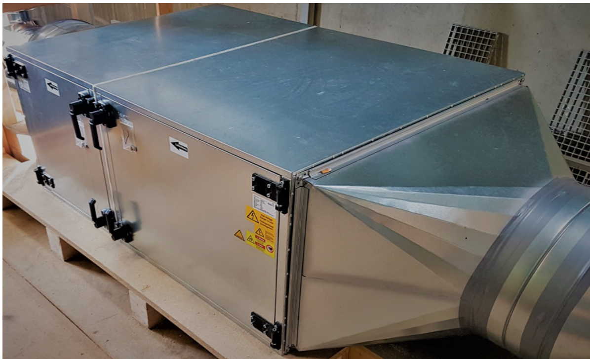
Abbildung 52: Gesamte Filterstufe in dem Drahtgestrick, Schwammfilter, elektrostatische Abscheider und Aktivkohlefilter angeordnet sind.
