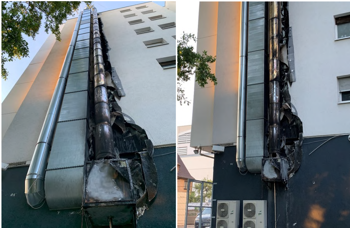
Abbildung 84: Beispiel für einen Fettbrand in der Abgasanlage einer Holzkohlegrillanlage.
