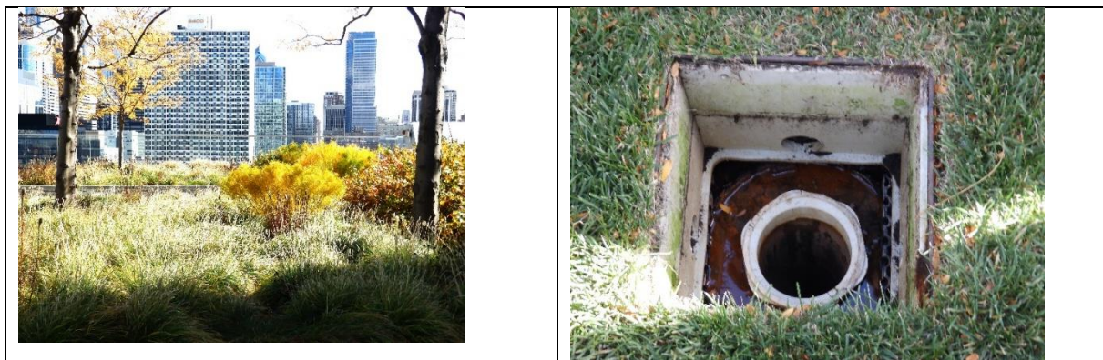
Abbildung 2: Gesamtansicht eines Retentionsdach mit der Qualität eines öffentlichen Stadtparks sowie der Detailblick in einen Revisionsschacht in der Rasenfläche
