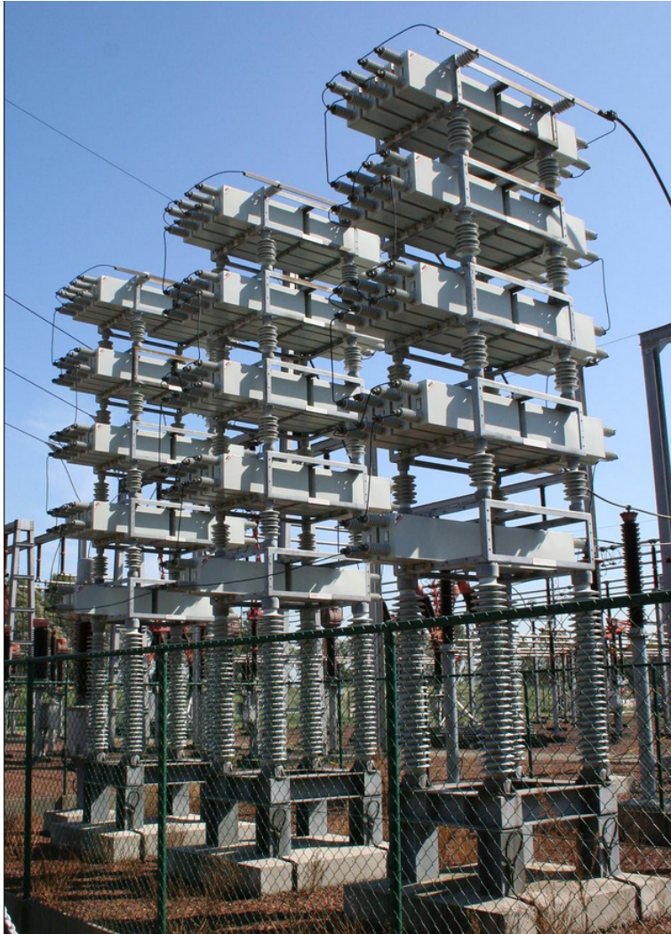
Abbildung 15: Kondensatorbatterie
