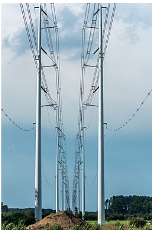
Abbildung 6: Wintrack-Kompaktmast in den Niederlanden
