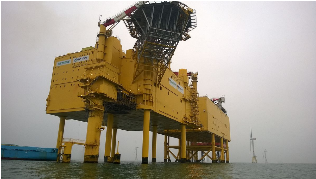
Abbildung 12: Konverterplattform
