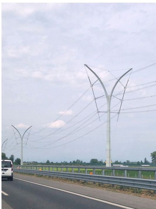
Abbildung 5: Germoglio-Kompaktmast in Italien
