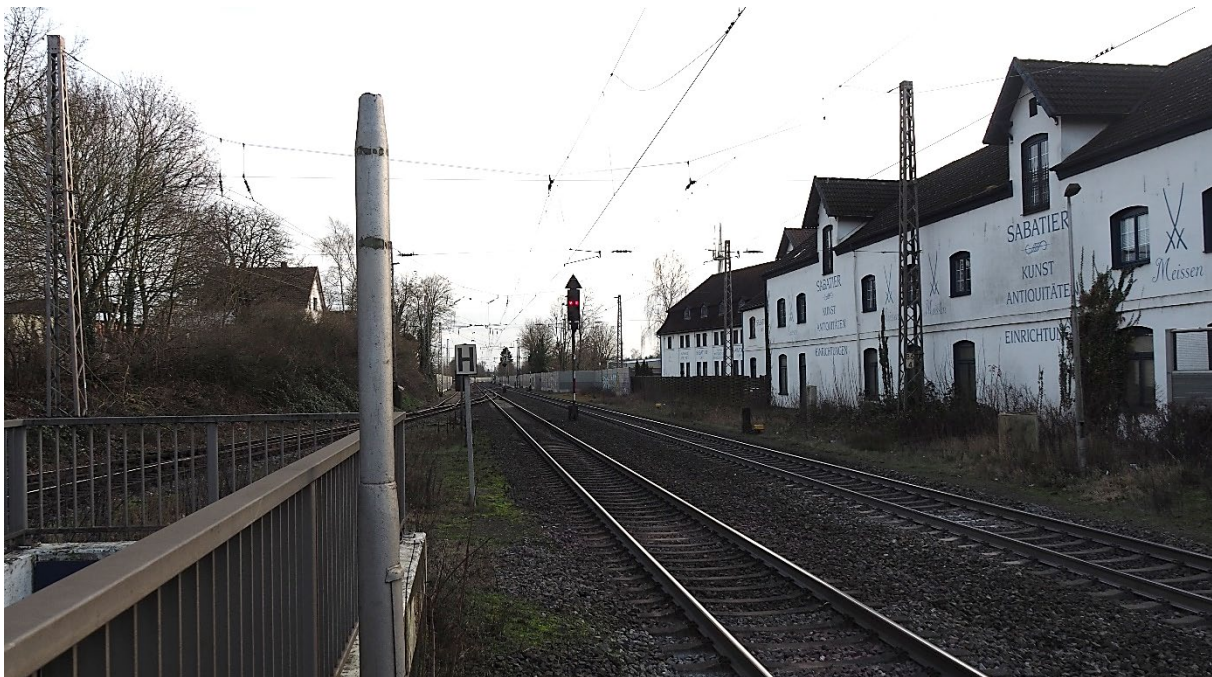
Abbildung 12: Bestandsgebäude an der Ausbaustrecke in Verden (Aller)
