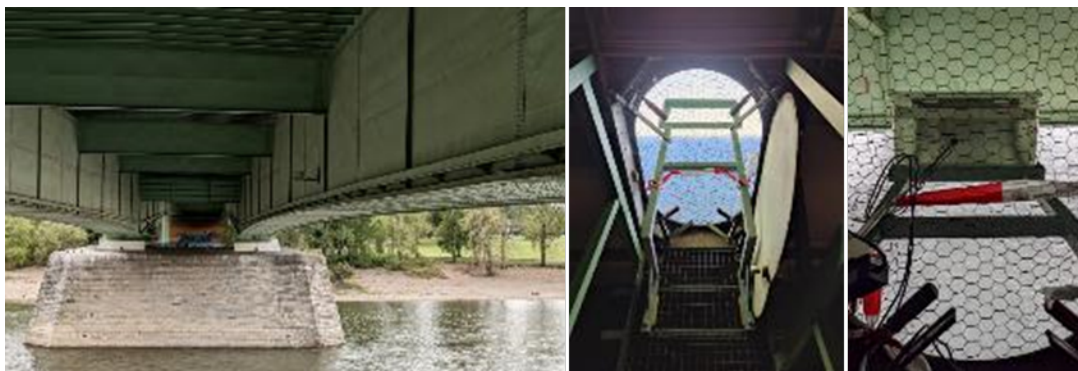
Abbildung 24: Aufbauten Zoobrücke Köln
