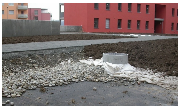
Abbildung 6: Drainage eines Tiefgaragendachs mit Bitumenbahn
