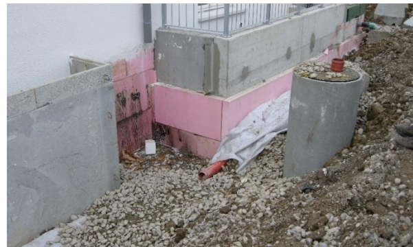
Abbildung 7: Muldenversickerung mit Anschluss an die Mischkanalisation
