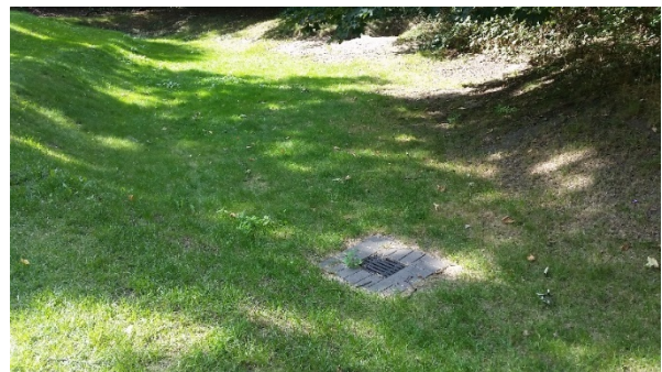
Abbildung 9: Versickerungsmulde, zusätzlich mit Ableitung in die Regenwasserkanalisation
