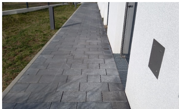
Abbildung 4: Wasserdurchlässiger Belag ohne Fugenbegrünung
